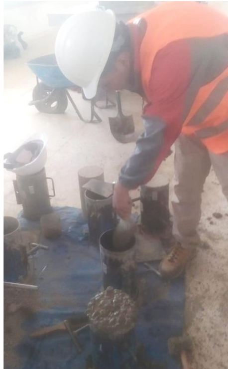
Fotografía 13. Desmolde de briquetas para su posterior curado
