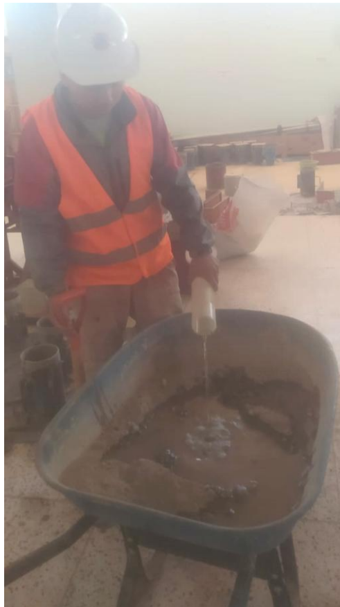
Fotografía 8. Mezcla de concreto convencional
