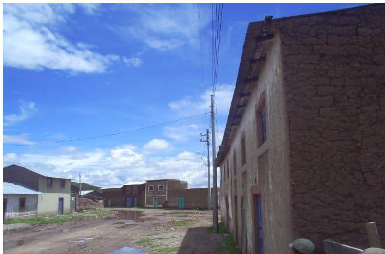
Edificaciones de adobe
