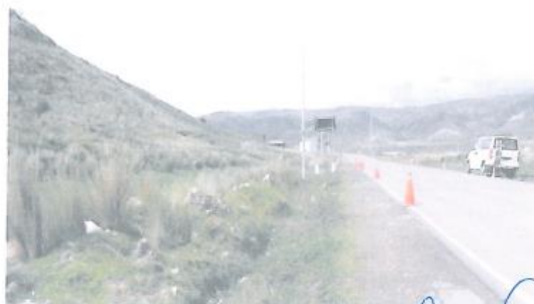
Falta Señalización Horizontal
