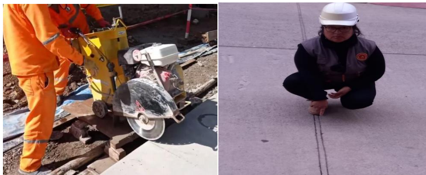
Figura 9: operador de equipo de corte realizando el aserrado
