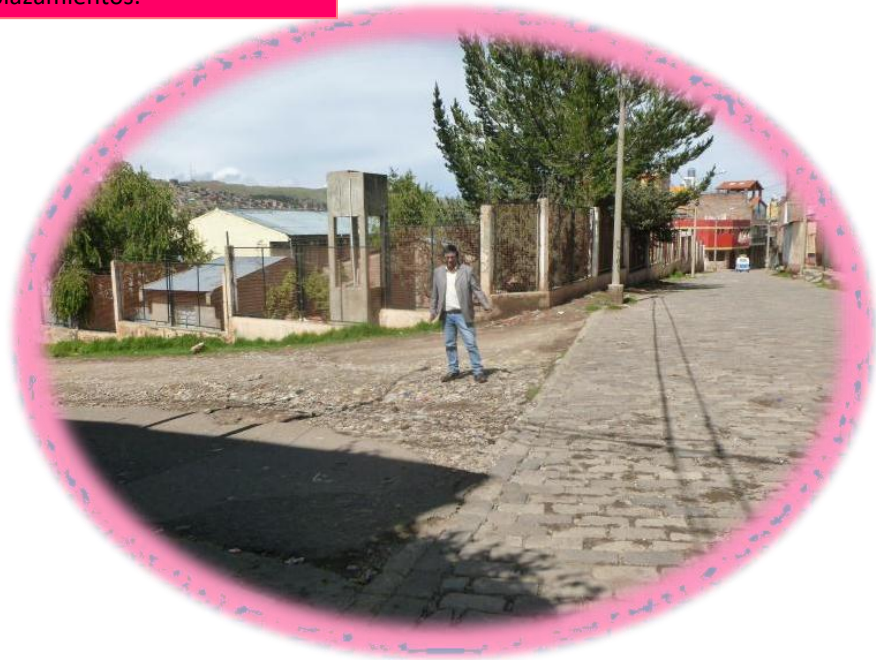
FOTOGRAFÍA N°10: DESPRENDIMIENTO EN EL JR. BOLOGNESI.- Al no estar pavimentadas las vías de intersección origina desplazamientos.
