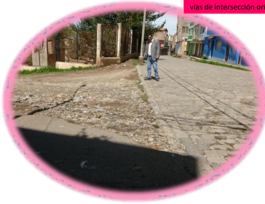
FOTOGRAFÍA N°10: DESPRENDIMIENTO EN EL JR. BOLOGNESI.- Al no estar pavimentadas las vías de intersección origina desplazamientos.
