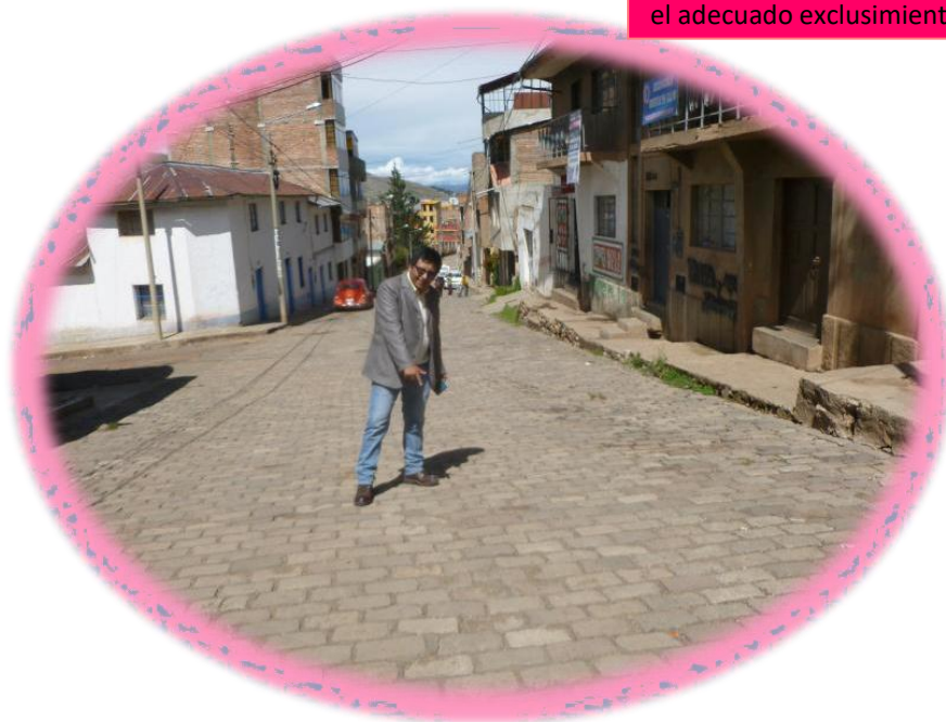
FOTOGRAFÍA N° 16: DEFORMACIONES EN EL JR. BOLOGNESI.- La falta de bombeo en la vía dificulta el adecuado exclusimientto de las aguas.
