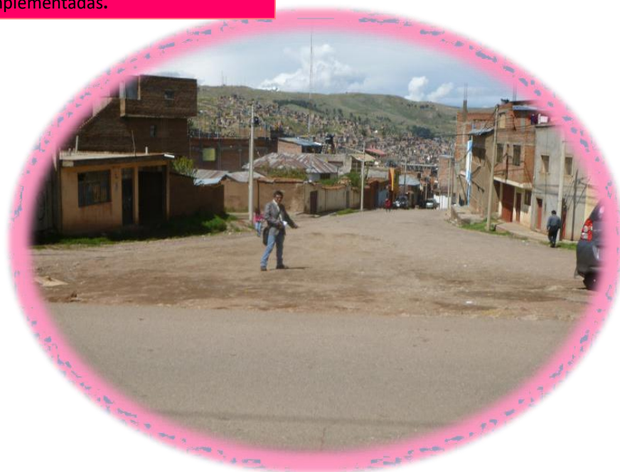
FOTOGRAFÍA N°22: DEFICIENTE TRANSICIÓN EN EL JR. BOLOGNESI.- El encuentro de dos tipos de pavimentos no es tan debidamente complementadas.
