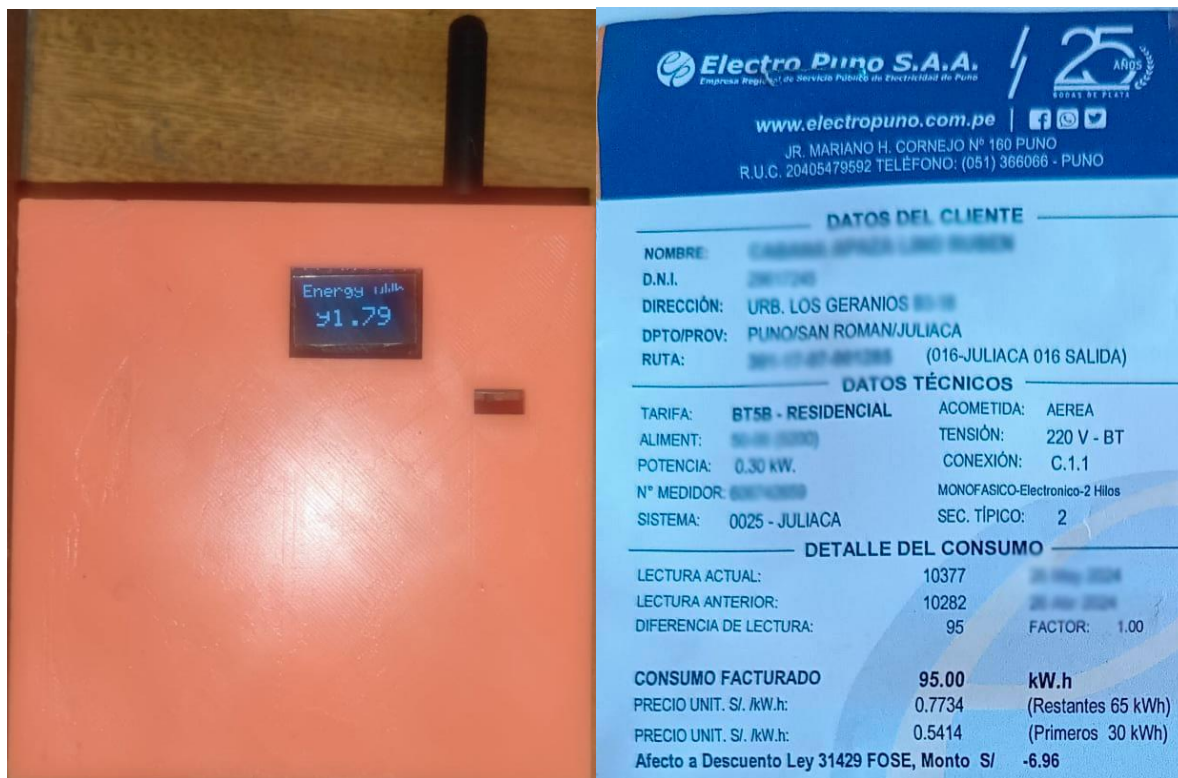
Figura 104: Comparación de obtención de datos del medidor de la concesionaria y el dispositivo de monitoreo
