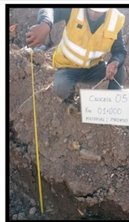
Fotografía 10 CALICATA 05 – terreno natural
