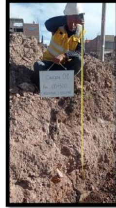
Fotografía 02 CALICATA 01 – material de relleno
