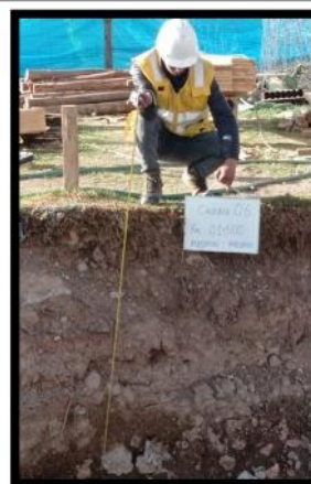
Fotografía 12 CALICATA 06 – terreno natural
