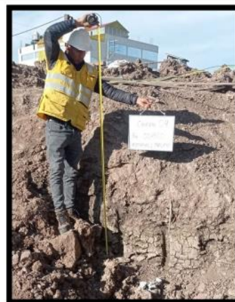
Fotografía 08 CALICATA 04 – terreno natural
