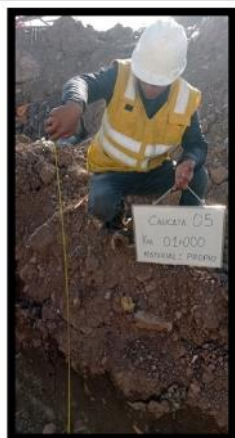
Fotografía 09 CALICATA 05 – terreno natural
