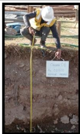
Fotografía 11 CALICATA 06 – terreno natural
