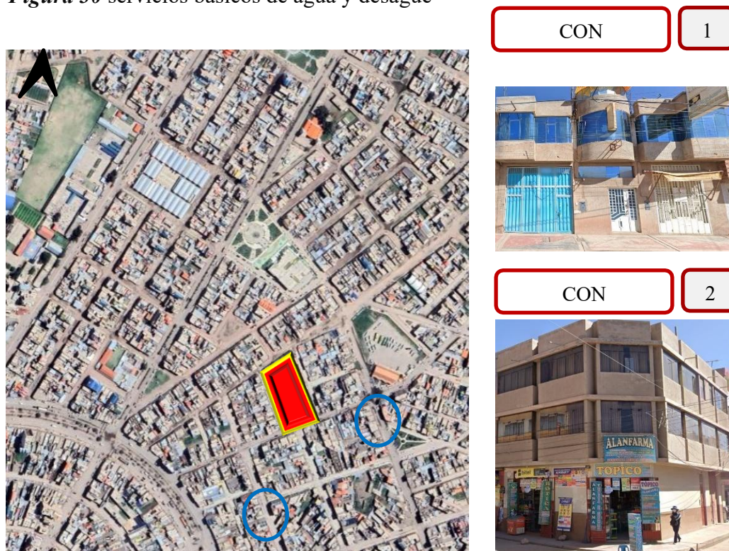
Figura 30 servicios básicos de agua y desagüe
