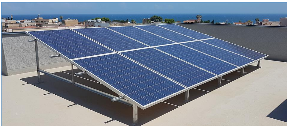
Figura 22. Ejemplo de instalación de estructura fija sobre superficie plana.
