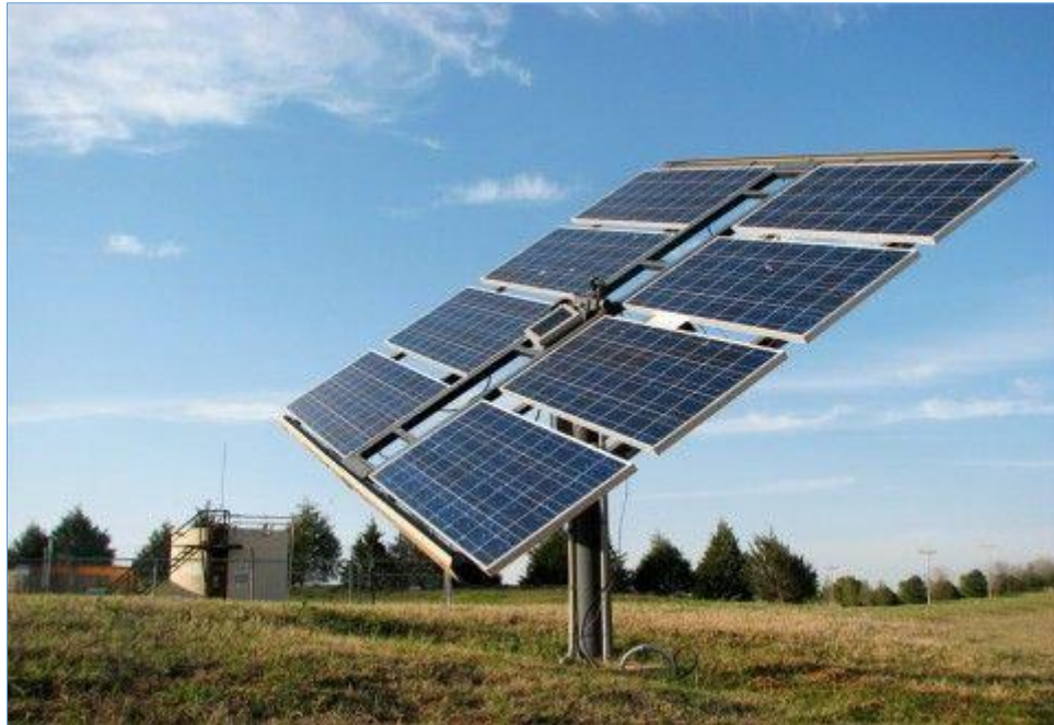
Figura 24. Ejemplo de instalación de estructura móvil sobre superficies plana.
