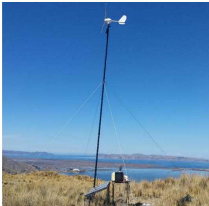
FIGURA 7. Instalación del módulo híbrido eólico- fotovoltaico
