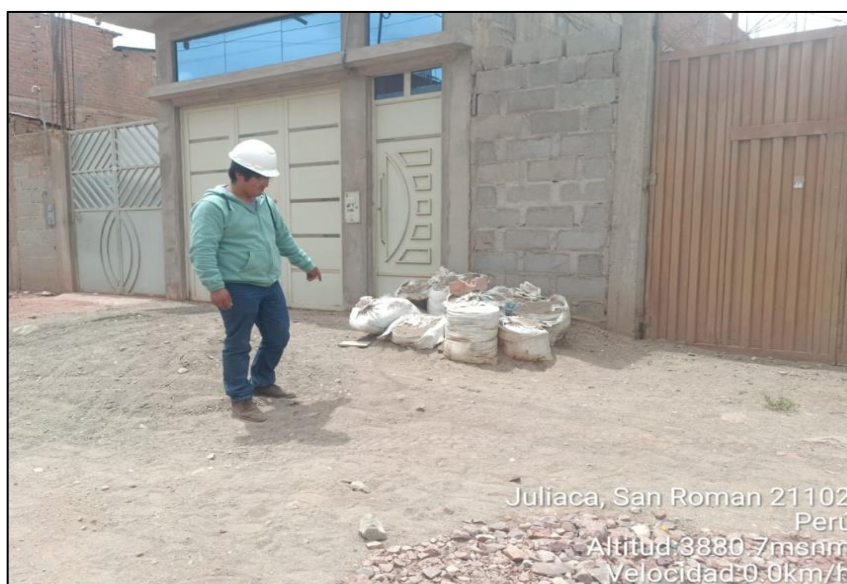
Fotografía 4. Acumulación de residuos de materiales de construcción (sacos, restos de cemento y agregados) generados durante el proceso constructivo de una edificación en la urbanización Aeropuerto, ciudad de Juliaca – 2025.
