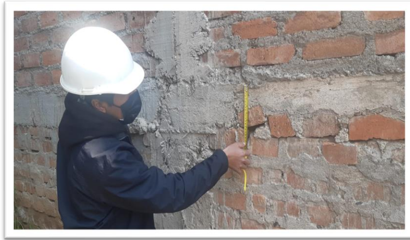
Imagen N° 06: La altura de la losa es de 0.20 m.
