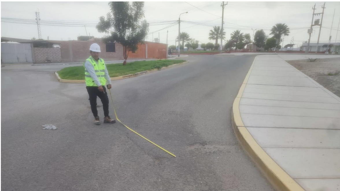
Ilustración 14 Tipo de fallo – grietas transversales y longitudinales.
