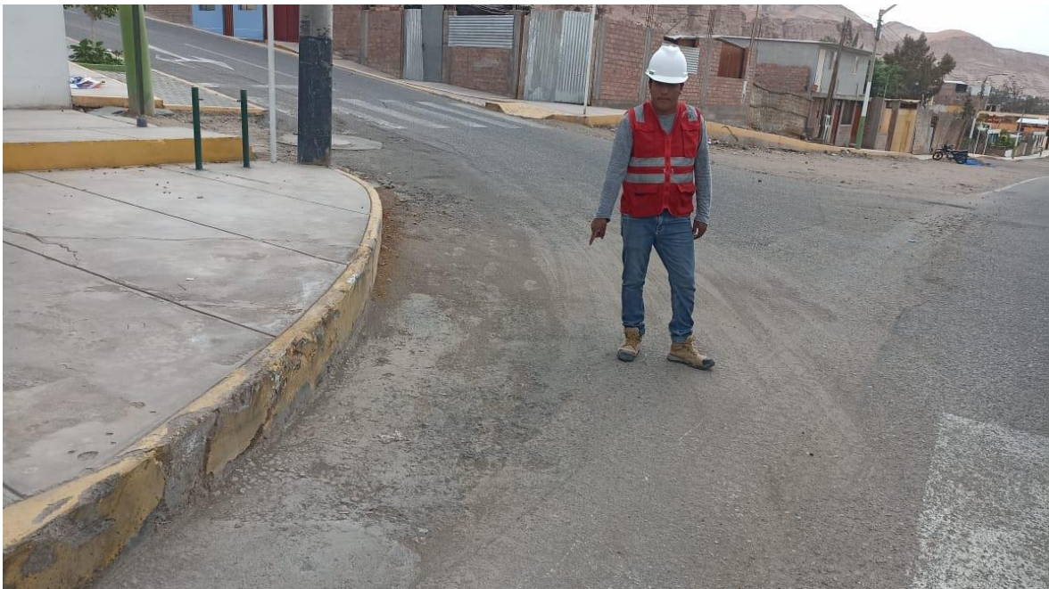
Ilustración 26 : Tipo de fallo – Ahuellamiento.
