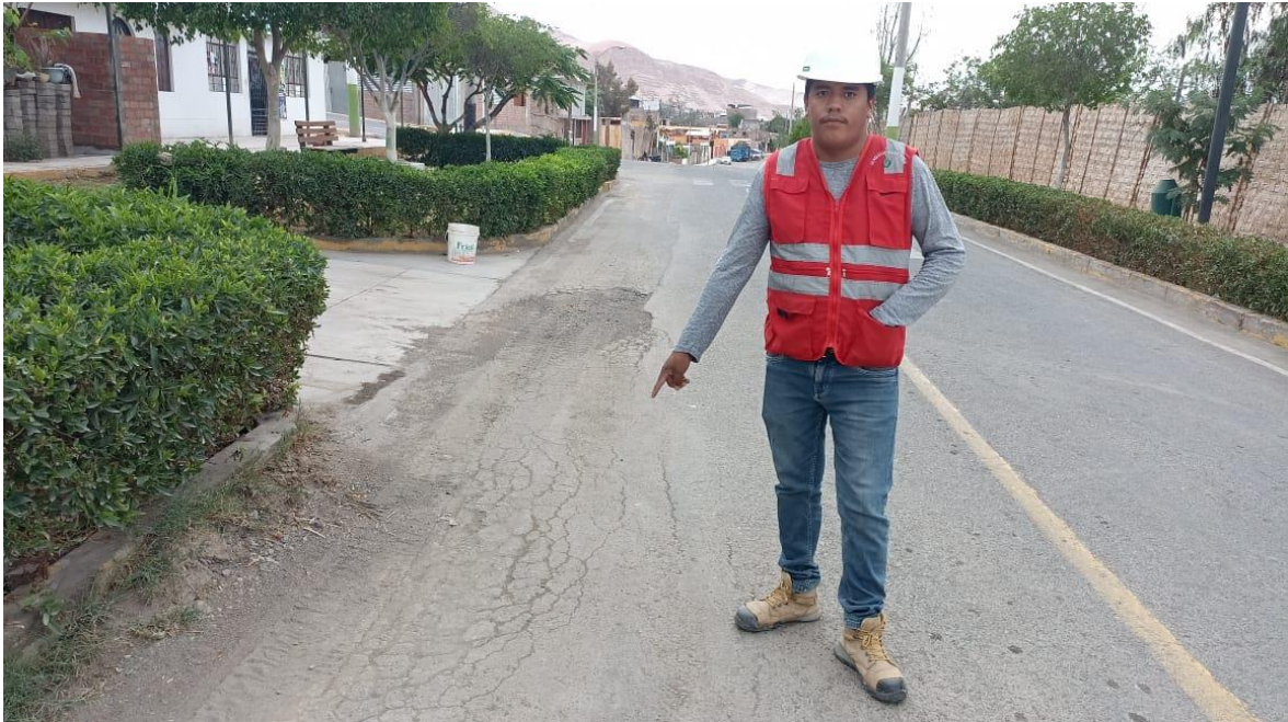
Ilustración 5: Tipo de fallo-piel de cocodrilo.
