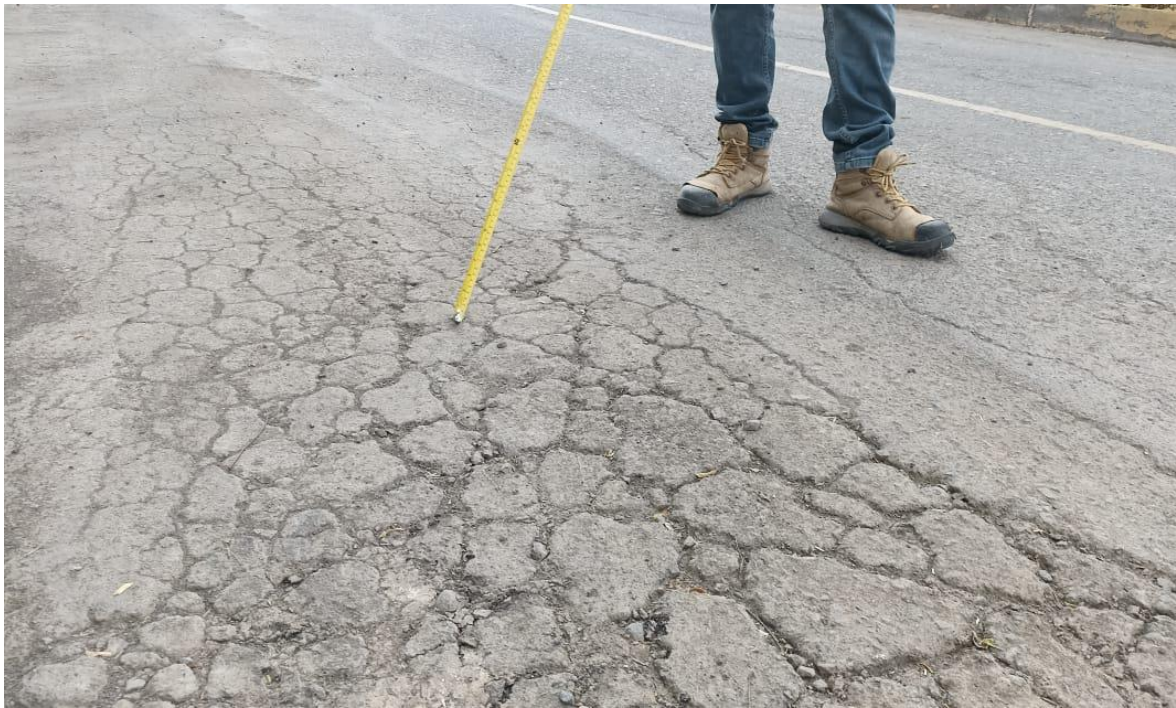
Ilustración 3 : Tipo de fallo-piel de cocodrilo.
