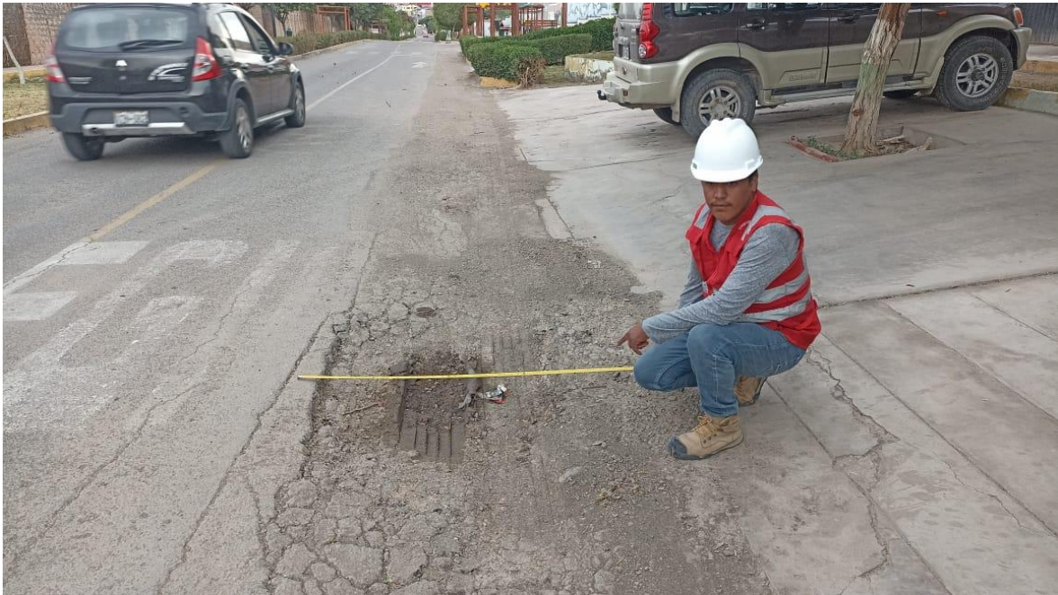
Ilustración 26 : Tipo de fallo – Ahuellamiento.
