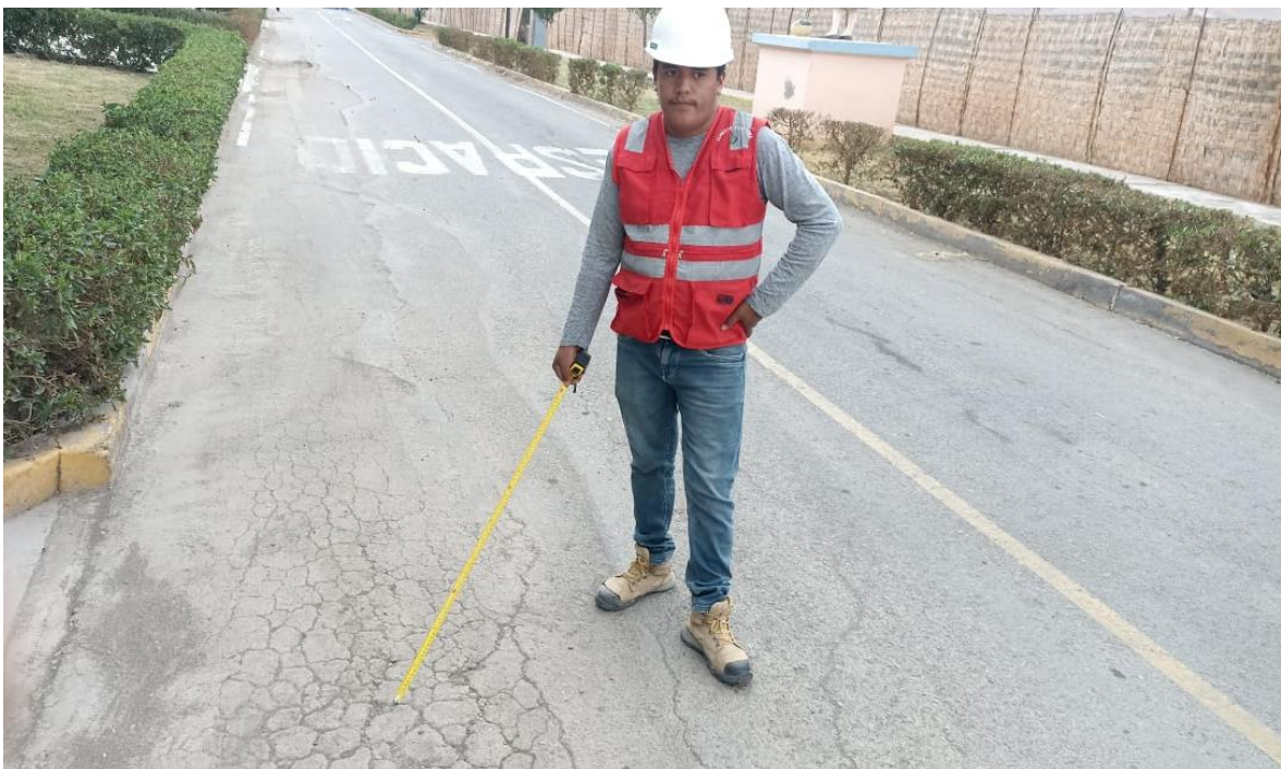
Ilustración 4: Tipo de fallo-piel de cocodrilo.
