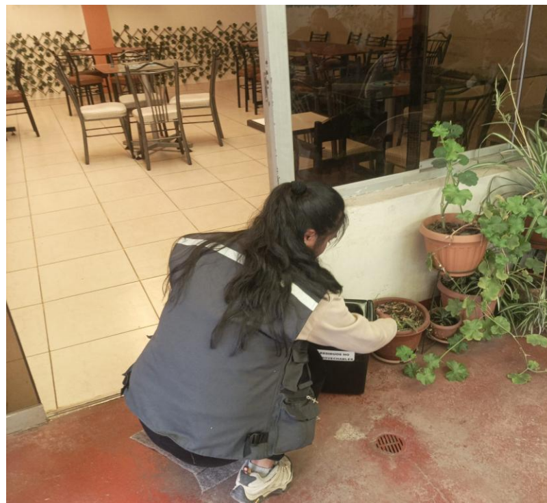
Fotografía 8. Instalación de contenedores para la gestión correcta de desechos sólidos en el tercer comedor del Eco Restaurante "Cevichería Las Brujas Pescados & Mariscos" del distrito de Puno.
