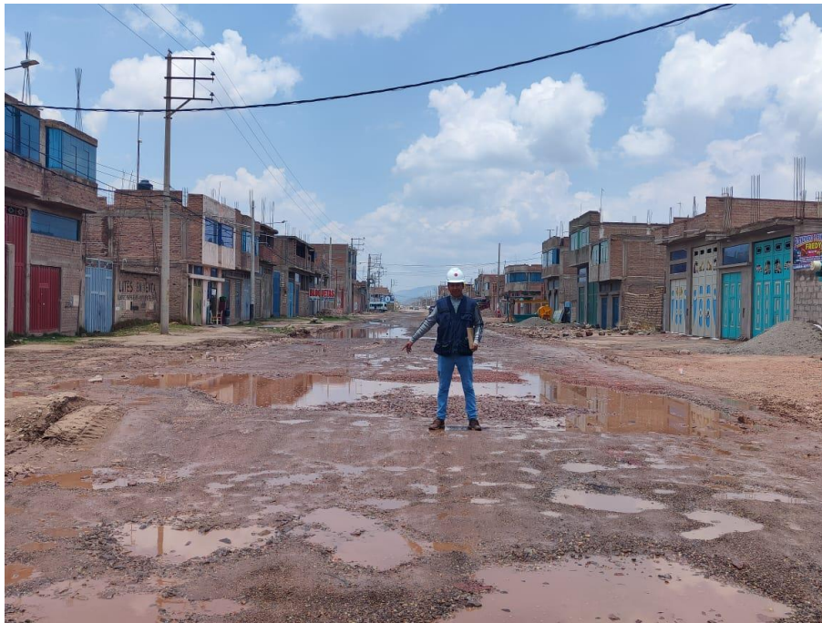
Fotografía 01. Verificación de la calzada de la Av. Lampa
