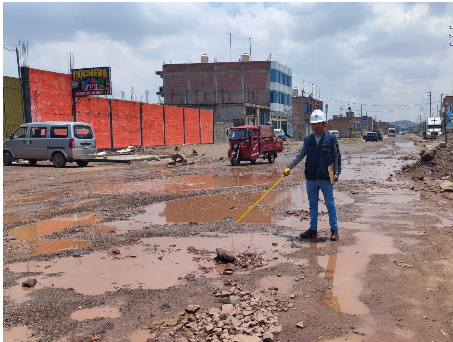
Fotografía 02. Verificación de la calzada de la Av. Lampa
