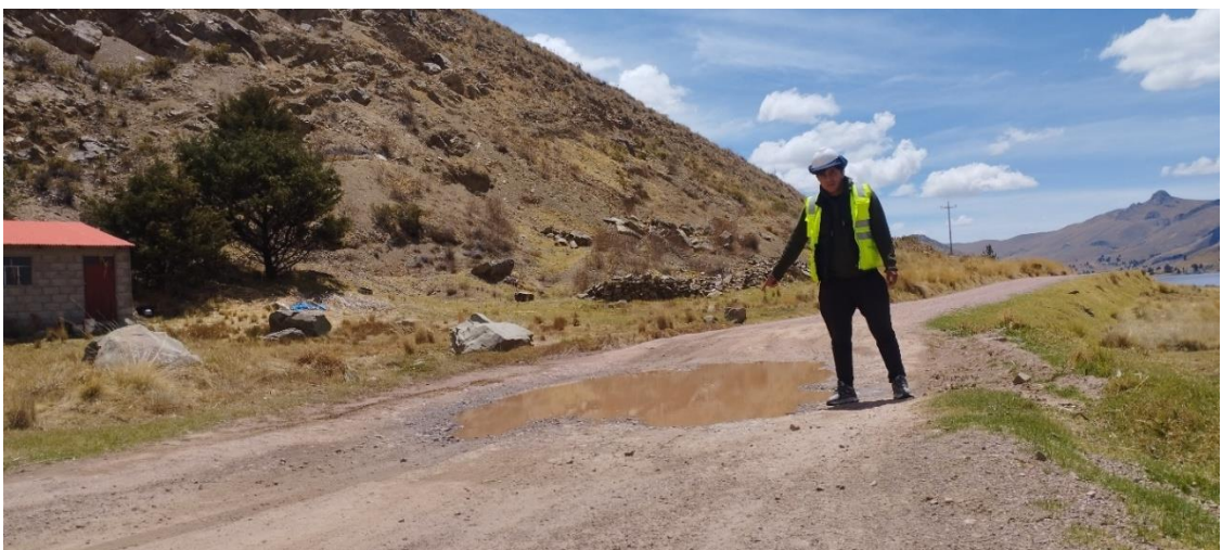
Fotografía 3. Lodazal grado 3 entre el km 16+310 y el km 16+320
