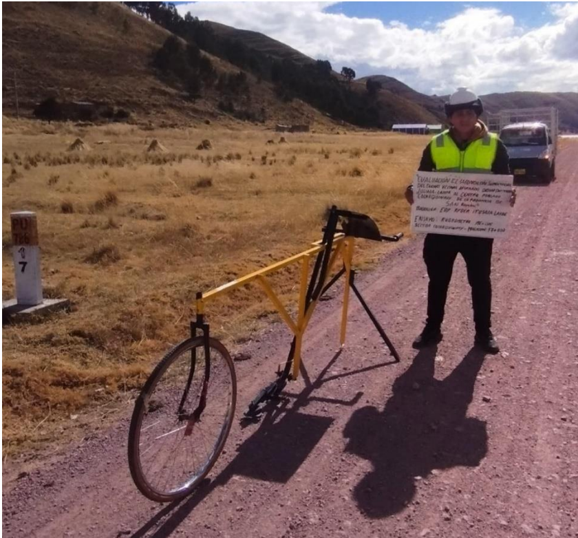
Fotografía 18. Tesista con todos sus EPPS en el km 17+000
