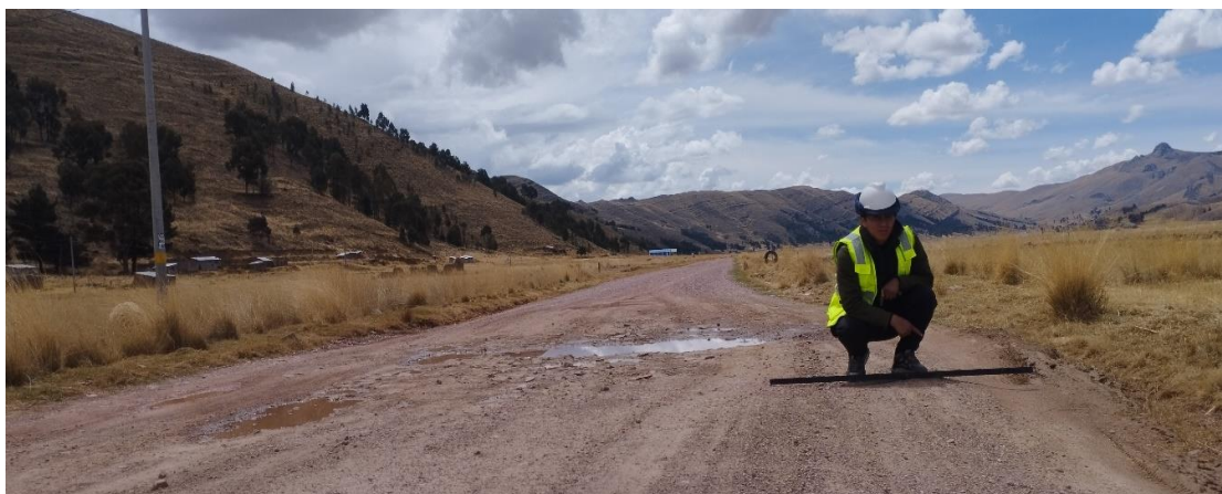
Fotografía 12. Deformación grado 3 entre el km 17+440 y el km 17+460
