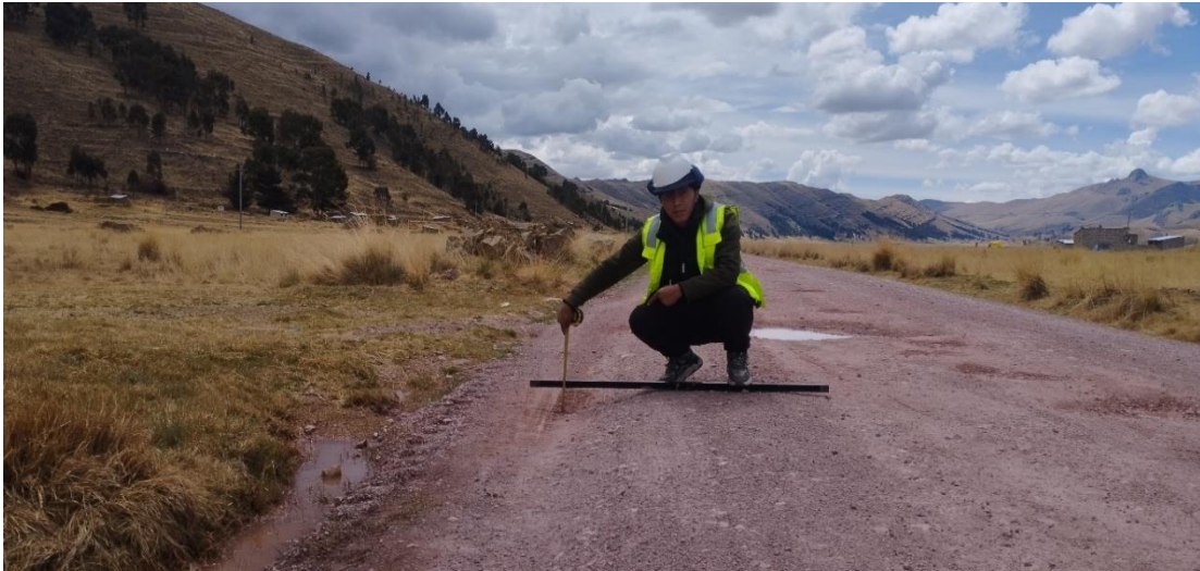
Fotografía 14. Baches de gravedad 1 entre el km 17+660 y el km 16+710
