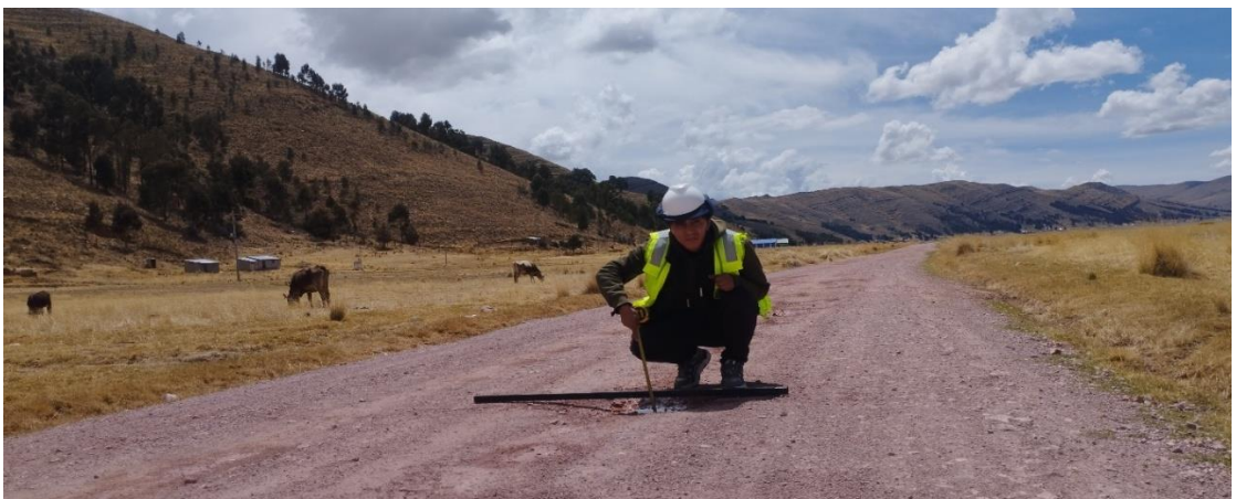
Fotografía 9. Baches(huecos) grado 2 entre el km 17+130 y el km 17+200
