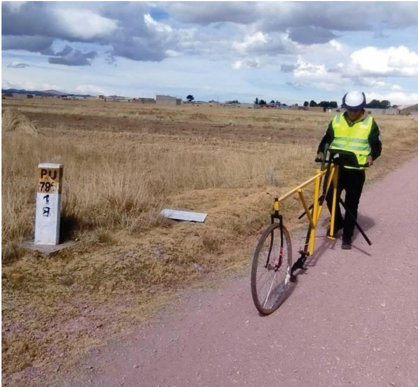
Fotografía 20. Finalizando las lecturas del rugosímetro merlín en el km 18+000
