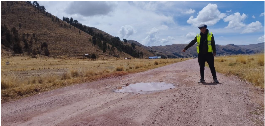
Fotografía 9. Baches(huecos) grado 2 entre el km 17+130 y el km 17+200
