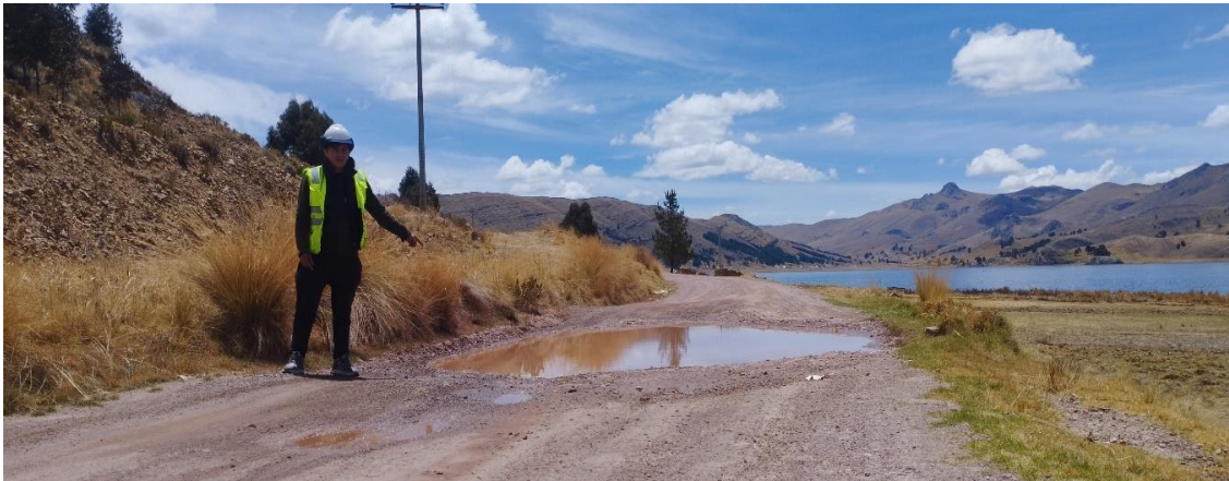
Fotografía 3. Lodazal grado 3 entre el km 16+310 y el km 16+320
