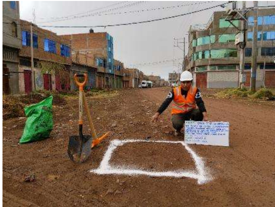
Fotografía 1. Calicata 1 avenida Republica
