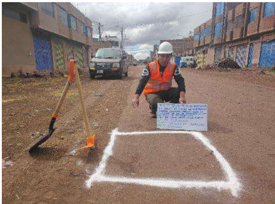
Fotografía 2. Calicata 2 Avenida Republica
