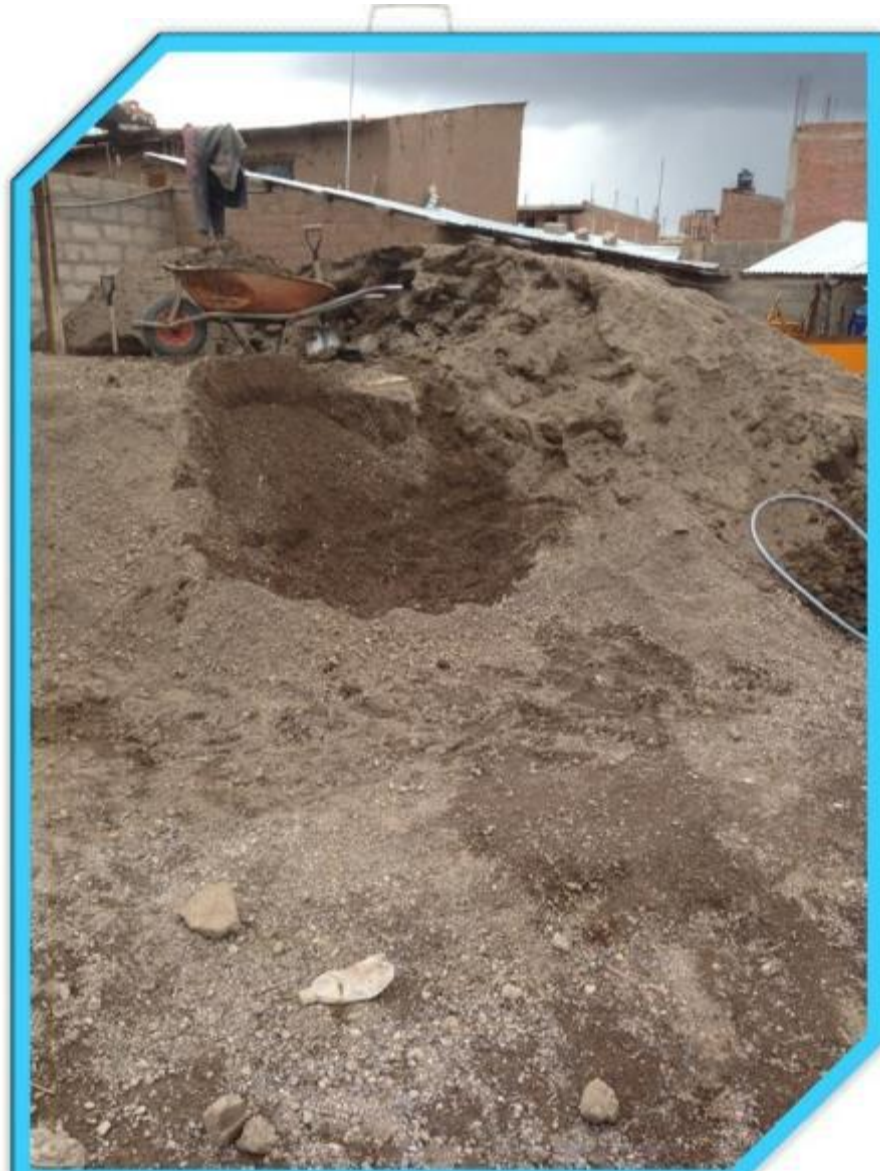
FOTOGRAFÍA 08: Área de producción de bloquetas, fábrica Cristina Vilca – Juliaca.
