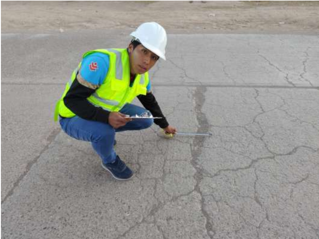
Fotografía 7. Medición y registro de fallas
