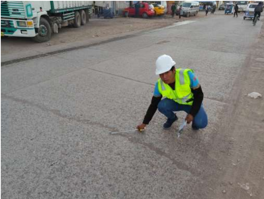
Fotografía 1. Medición de la Falla 23 (losa dividida), ubicado en el tramo 0+00-0+060 km.
