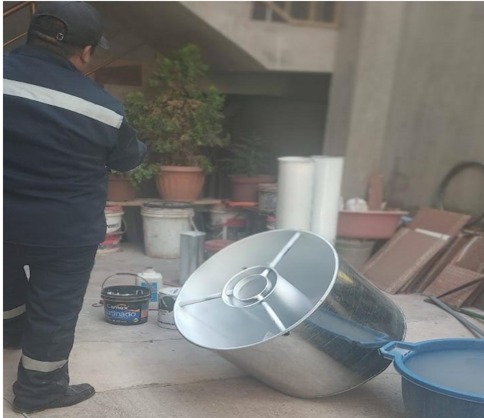
Fotografía 2. Etapa de pintado de los 3 tanques externa e internamente
