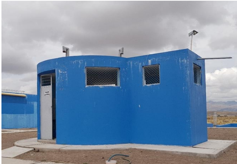
Estación de Bombeo
