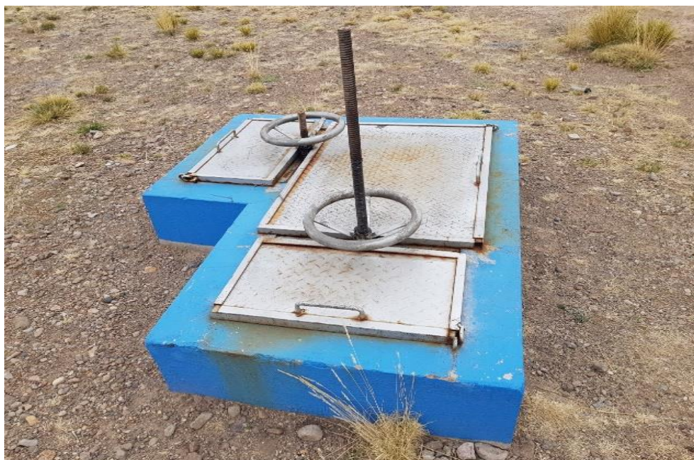
Cámara de demasías.
