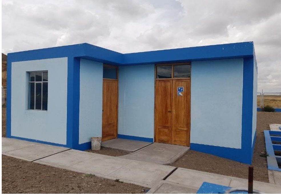
Caseta de cloración
