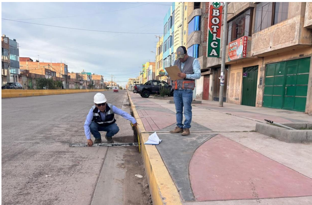
Fotografía 1.- Registro en campo de las dimensiones reales (ancho, tirante y geometría transversal) y evaluación del estado físico de conservación y mantenimiento de la cuneta.
