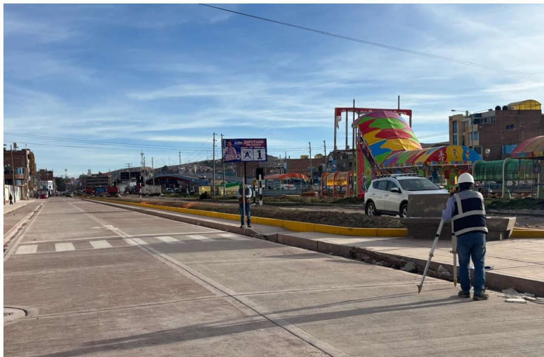
Fotografía 8.- Levantamiento altimétrico para la evaluación de las pendientes longitudinales reales de las cunetas de concreto en el tramo analizado.
