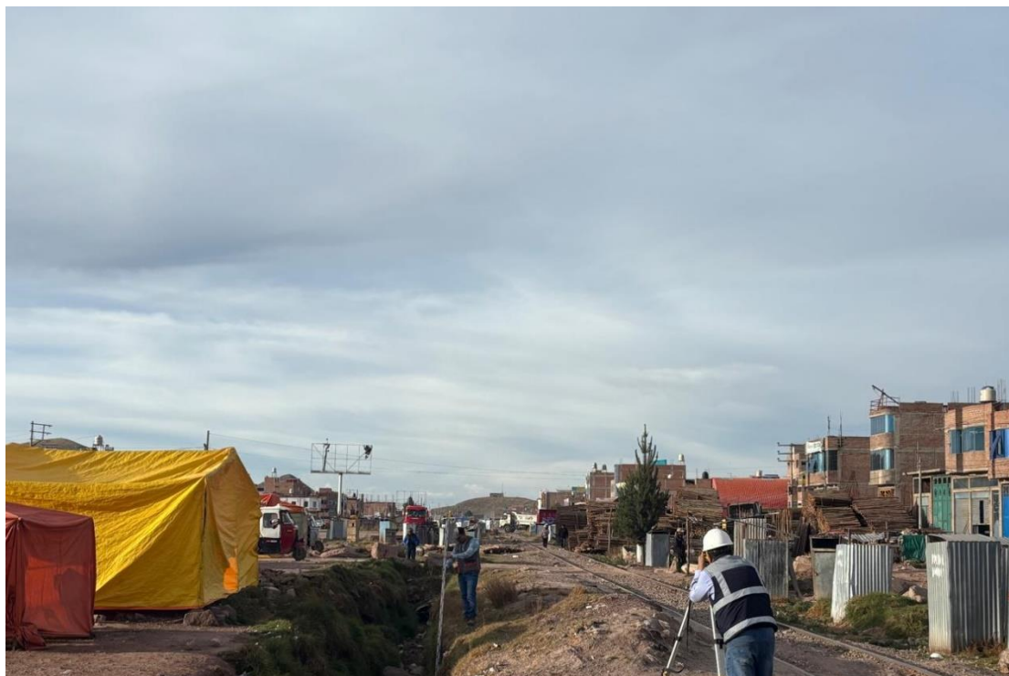
Fotografía 7.- Levantamiento altimétrico de las alcantarillas de sección Circular (TMC), orientado a la evaluación de cotas, pendientes y condiciones hidráulicas de operación.
