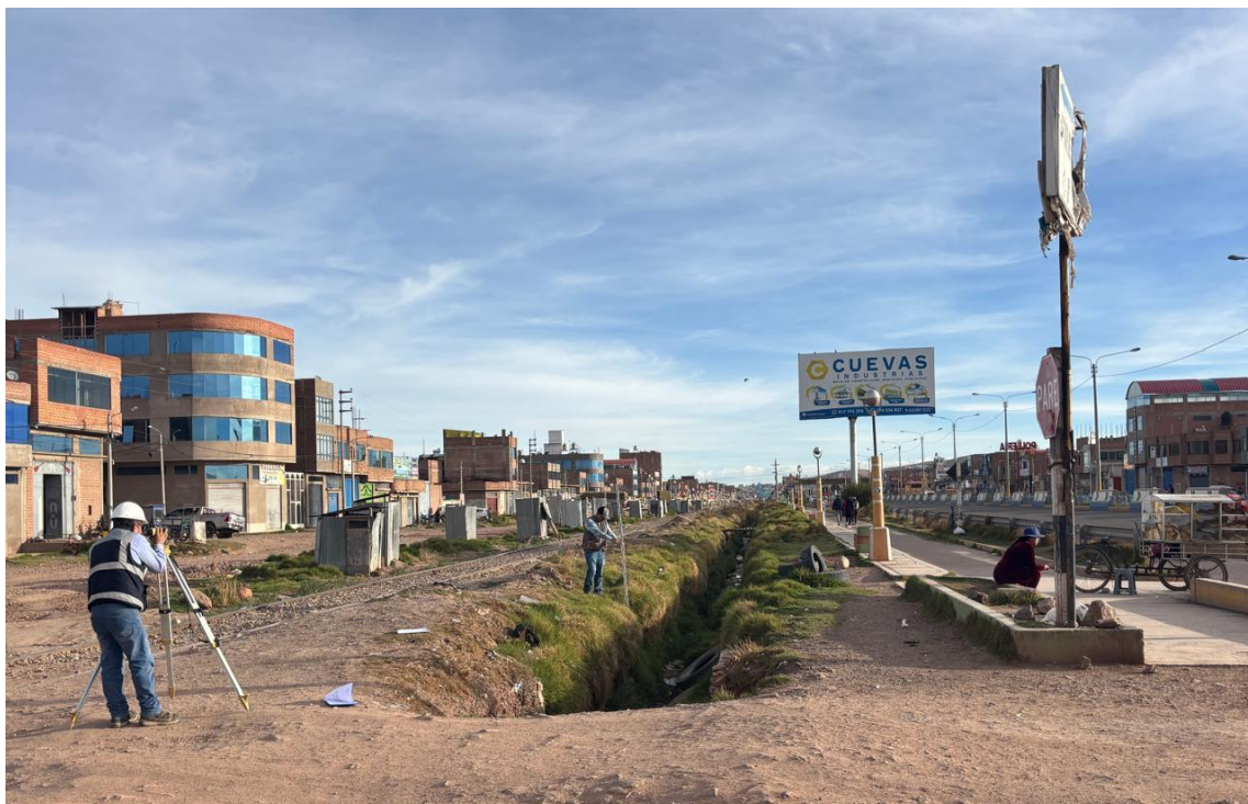
Fotografía 5.- Levantamiento altimétrico de las alcantarillas, orientado a la evaluación de cotas, pendientes y condiciones hidráulicas de operación-
