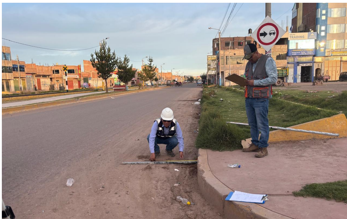
Fotografía 8.- Registro en campo de las dimensiones reales (ancho, tirante y geometría transversal) y evaluación del estado físico de conservación y mantenimiento de la cuneta.
