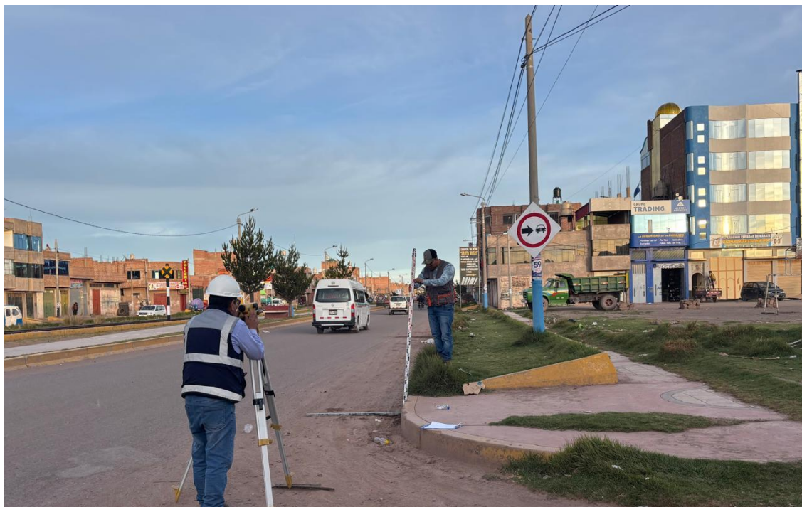
Fotografía 7.- Levantamiento alimétrico para la evaluación de las pendientes longitudinales reales de las cunetas de concreto en el tramo evaluado.
