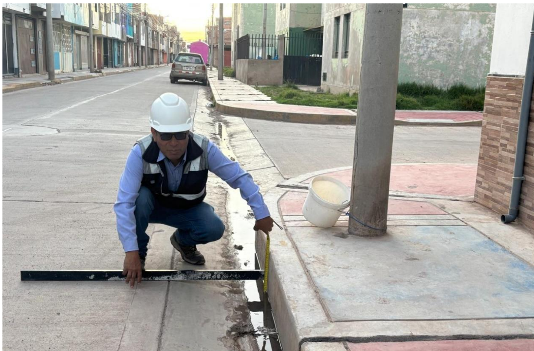
Fotografía 3.- Registro en campo de las dimensiones reales (ancho, tirante y geometría transversal) y evaluación del estado físico de conservación y mantenimiento de la cuneta.
