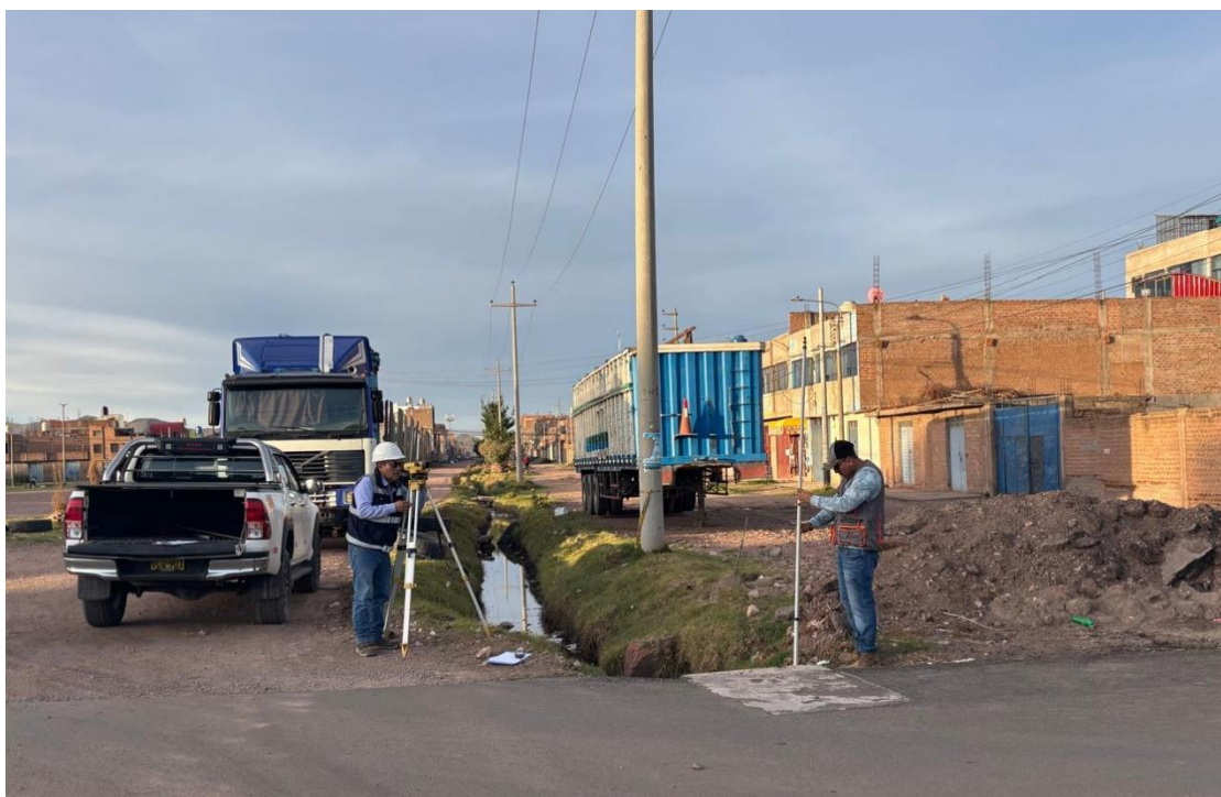
Fotografía 4.- Levantamiento altimétrico para la evaluación de las pendientes longitudinales reales de las cunetas de concreto en el tramo evaluado.
