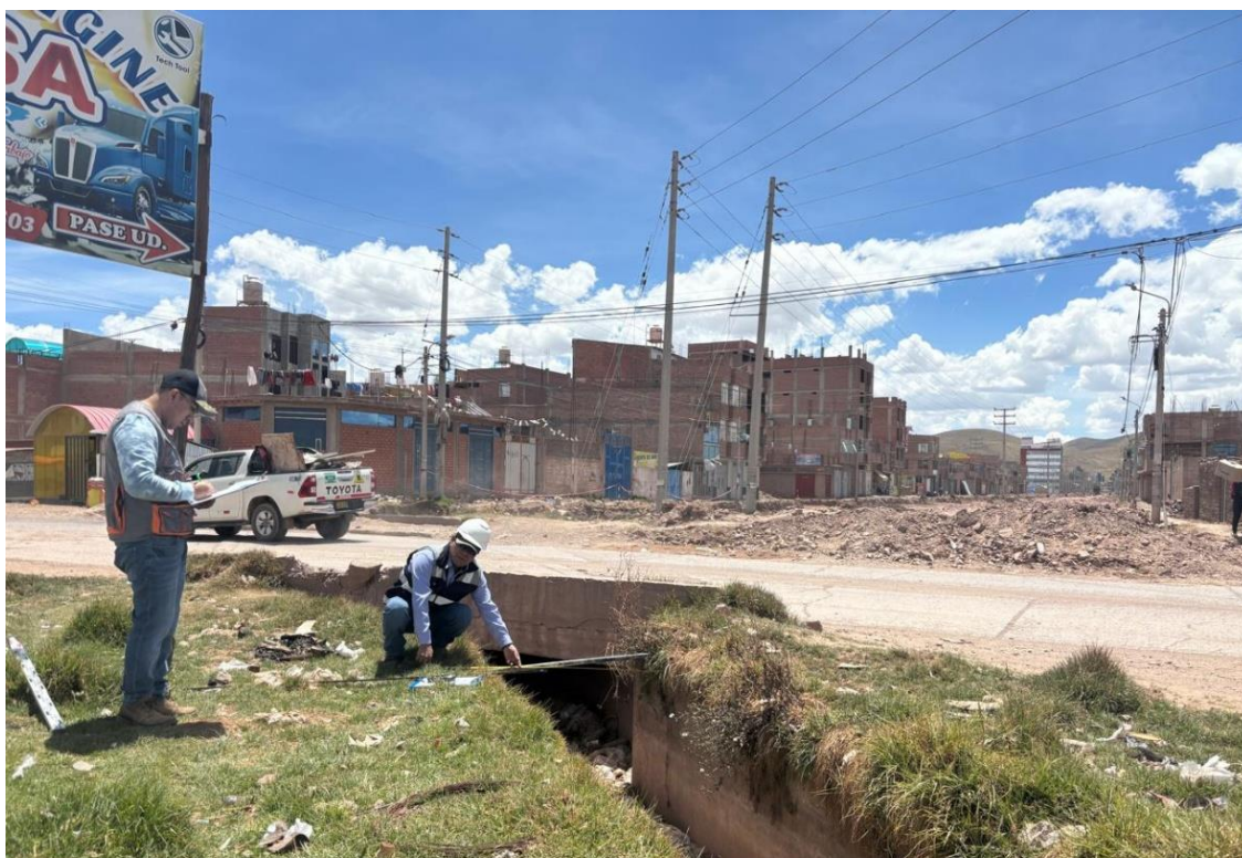
Fotografía 3.-Toma de datos geométricos en campo de las alcantarillas existentes, considerando dimensiones internas y estado físico de conservación y mantenimiento de la estructura.
