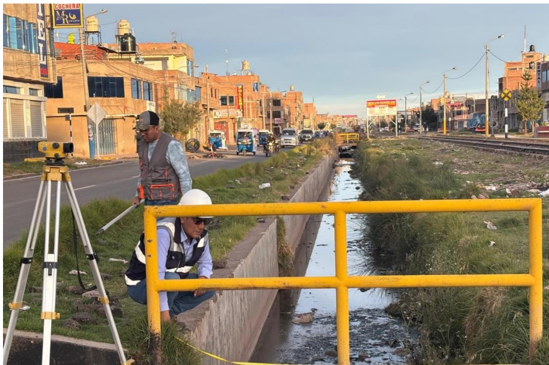
Fotografía 5.- Registro en campo de las dimensiones reales (ancho, tirante y geometría transversal) y evaluación del estado físico de conservación y mantenimiento de la alcantarilla.
