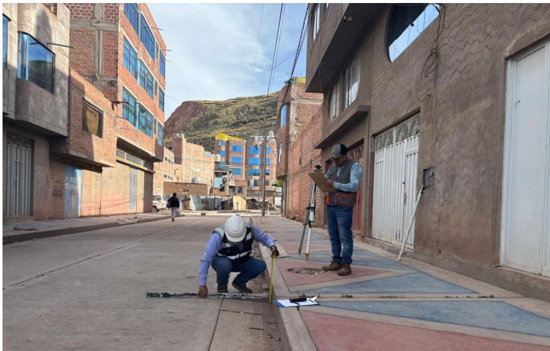
Fotografía 1.- Registro en campo de las dimensiones reales (ancho, tirante y geometría transversal) y evaluación del estado físico de conservación y mantenimiento de la cuneta.
