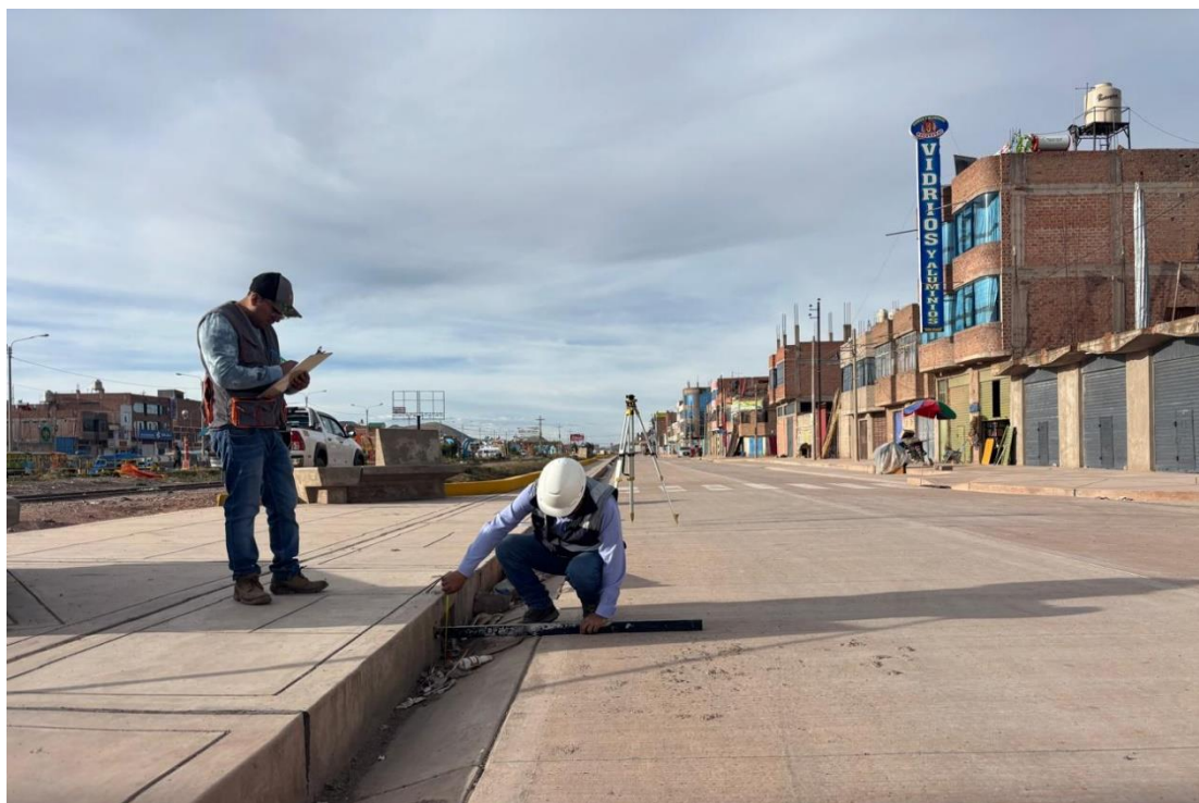
Fotografía 4.- Registro en campo de las dimensiones reales (ancho, tirante y geometría transversal) y evaluación del estado físico de conservación y mantenimiento de la cuneta.
