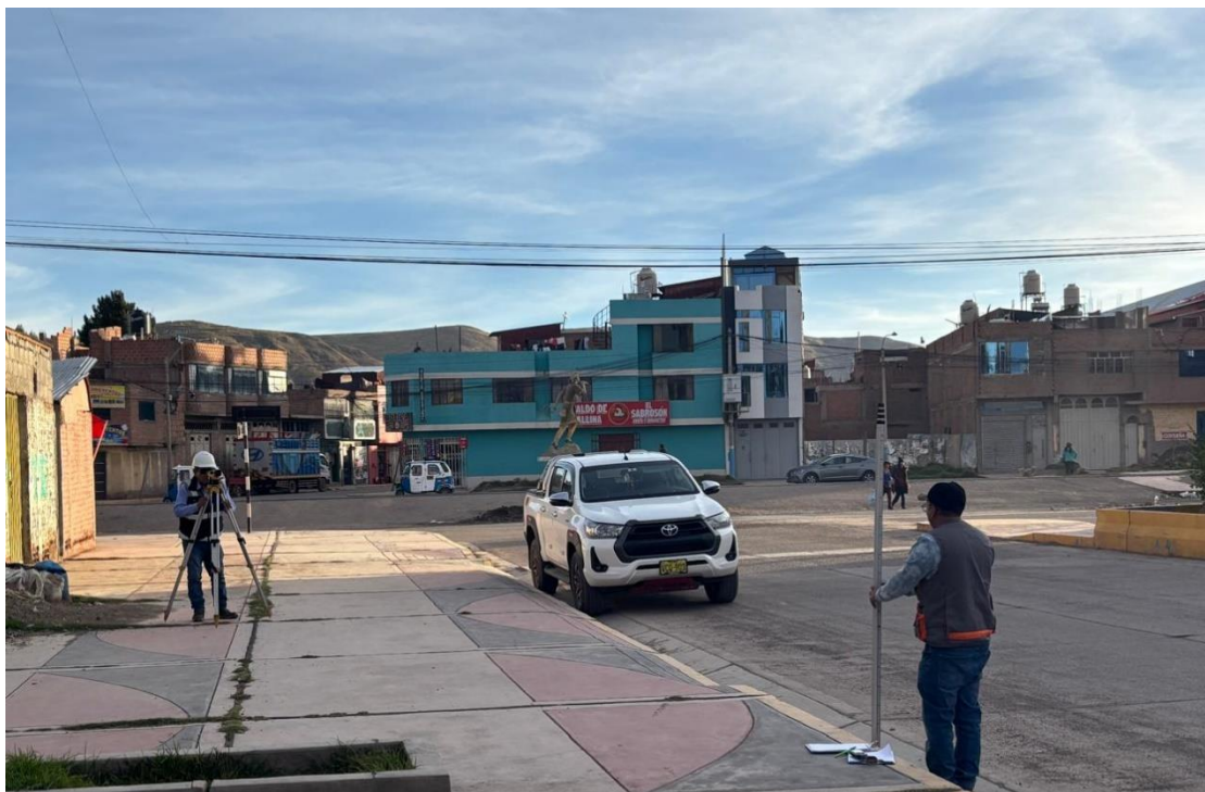
Fotografía 3.- Levantamiento altimétrico para la evaluación de las pendientes longitudinales reales de las cunetas de concreto en el tramo evaluado.
