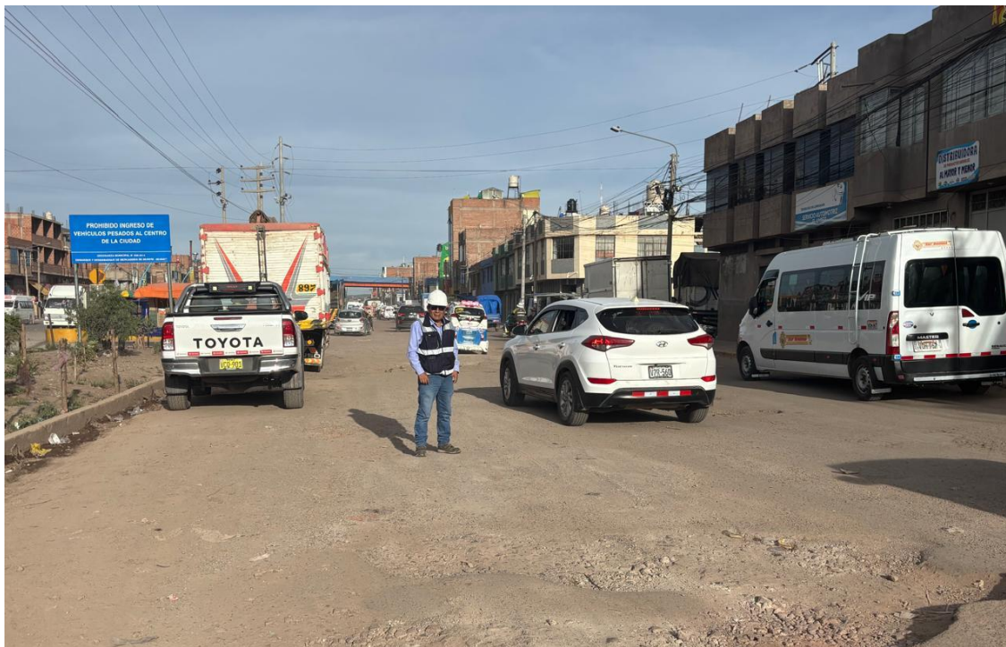
Fotografía 1.- Levantamiento altimétrico para la evaluación de las pendientes longitudinales reales de las cunetas de concreto en el tramo analizado.
