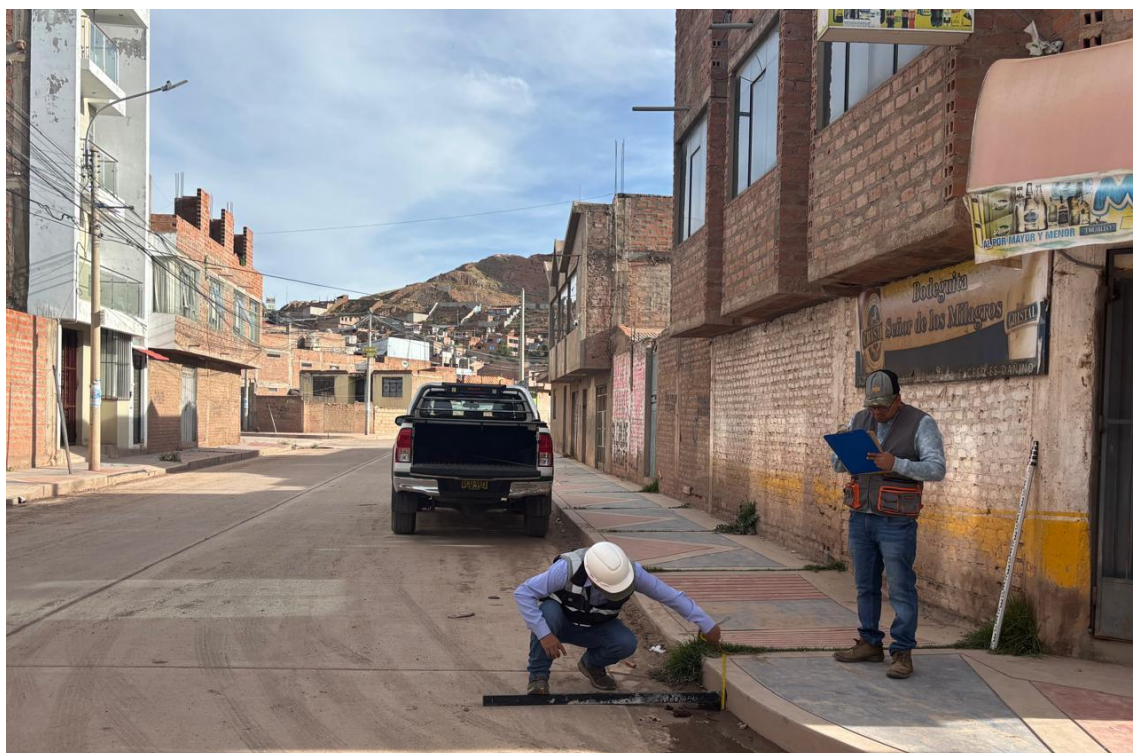
5.- Registro en campo de las dimensiones reales (ancho, tirante y geometría transversal) y evaluación del estado físico de conservación y mantenimiento de la cuneta.
