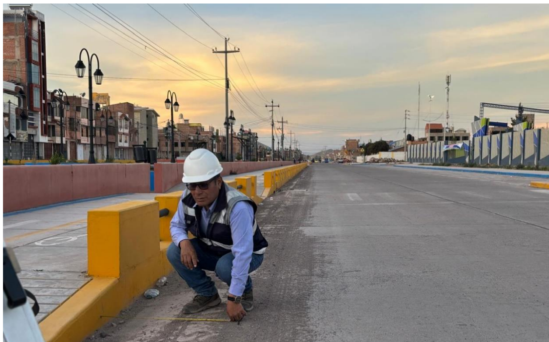
Fotografía 5.- Registro en campo de las dimensiones reales (ancho, tirante y geometría transversal) y evaluación del estado físico de conservación y mantenimiento de la cuneta.
