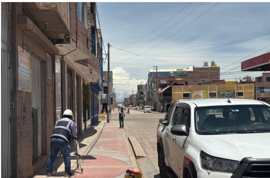
Fotografía 2.- Levantamiento alimétrico para la evaluación de las pendientes longitudinales reales de las cunetas de concreto en el tramo analizado.
