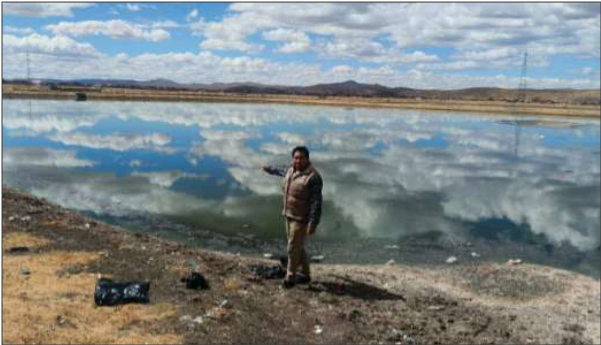
Fotografía N° 03: Aguas residuales de la PTAR - Chilla
