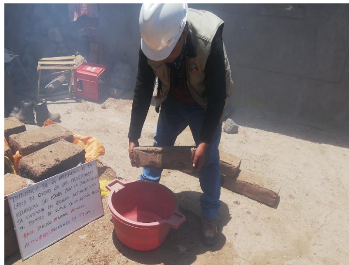
Humedecimiento de las caras de adobe.
