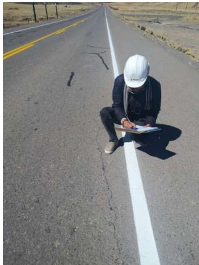
Fotografía 6. Grieta de reflexión de junta en la vía.
