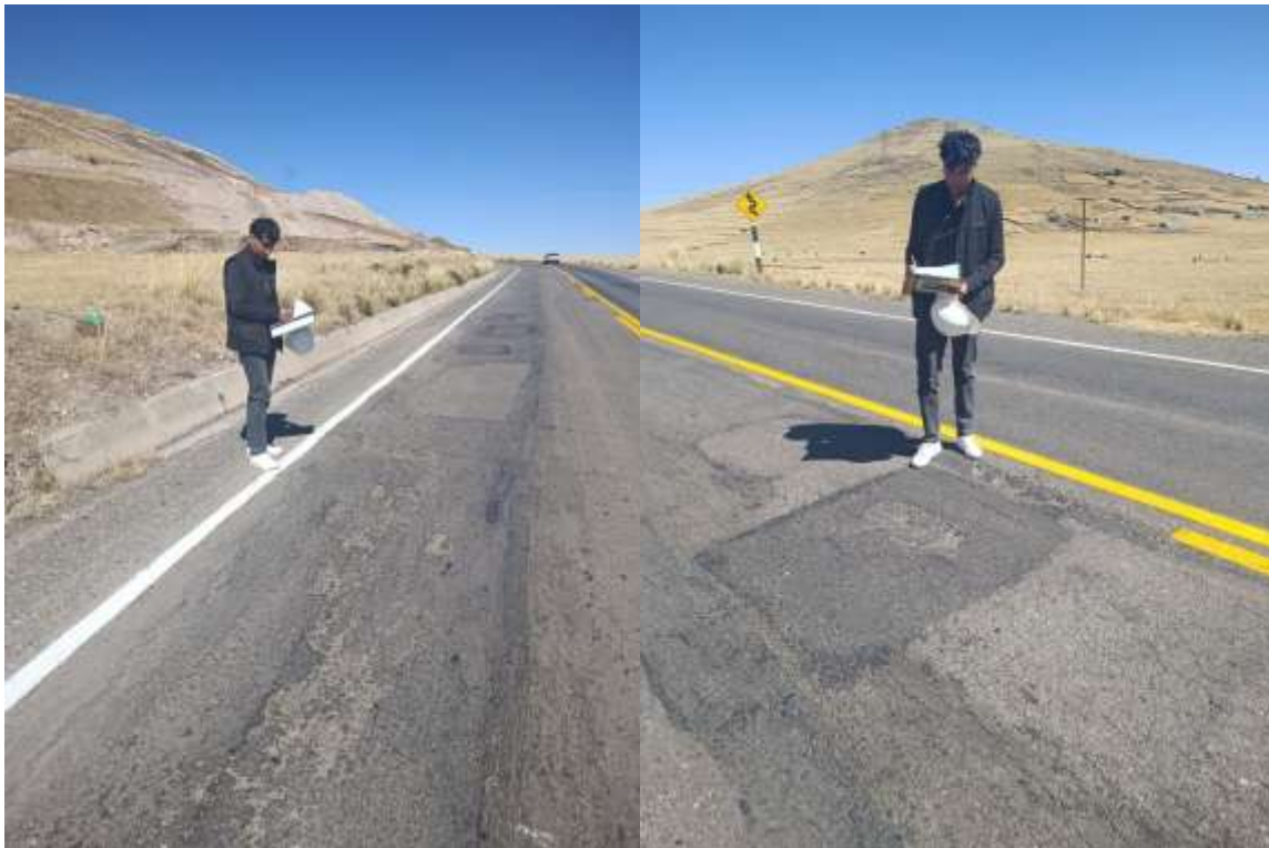
Fotografía 3. Parcheo en la vía.
