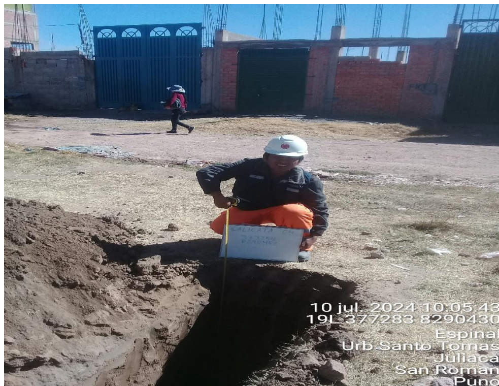
Figura 22. Extracción de muestras de muestra inalterada de la calicata 04. P. Palomino 2024
