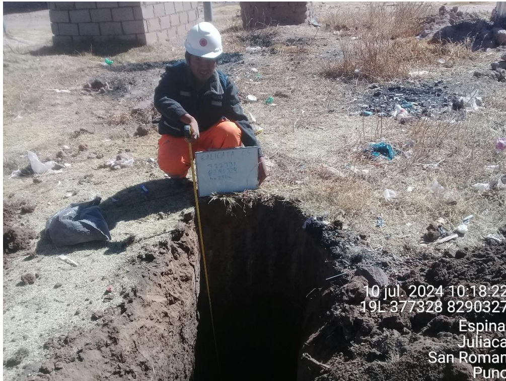
Figura 24. Ensayo de contenido de humedad de la capacidad portante de cimentación inalterado de la Urbanización Santo Tomas. E. Vilcapaza 2024
