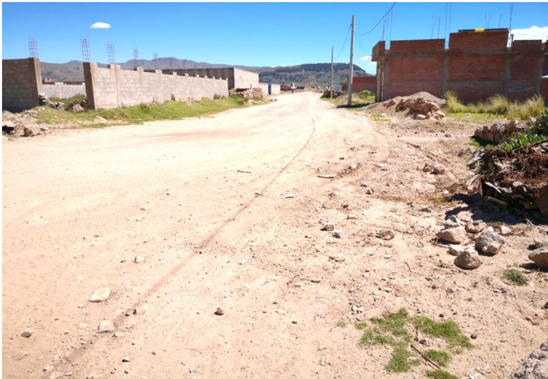
Figura 5 ESTADO ACTUAL DE LA VÍA
