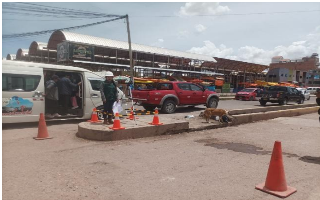
Trabajo de campo de la investigación y cercado con conos de seguridad
