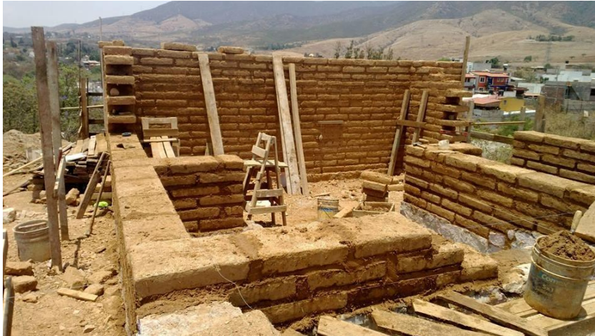
Tabique de adobe
