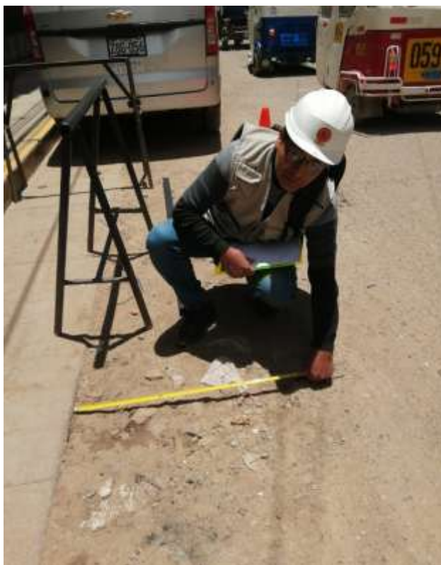
Fotografía 9. Tipo de falla hueco de severidad media en la progresiva 0+880 – 0+919.
