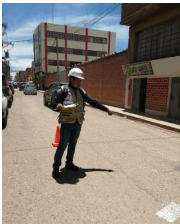
Fotografía 6. Tipo de falla grieta de reflexión de junta de severidad baja.
