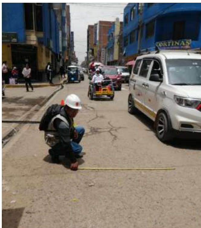
Fotografía 3. Tipo de falla piel de cocodrilo y fisuras transversales en severidad media.
