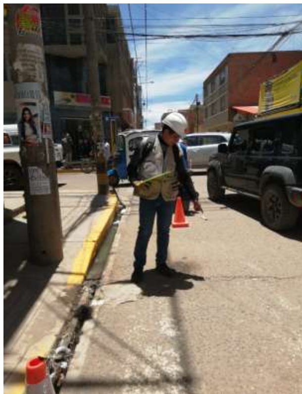
Fotografía 10. Tipo de fallas grietas longitudinales y transversales
