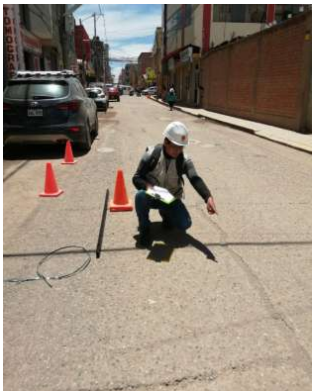
Fotografía 7. Tipo de falla grieta de reflexión de junta de severidad media en la UM - 07.
