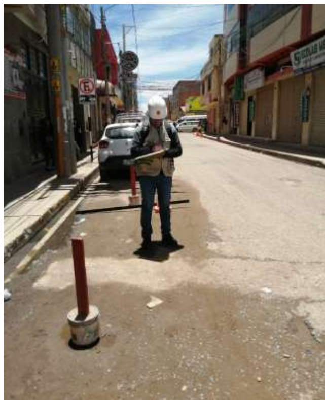
Fotografía 8. Tipo de fallas huecos y grietas de borde en severidad media.
