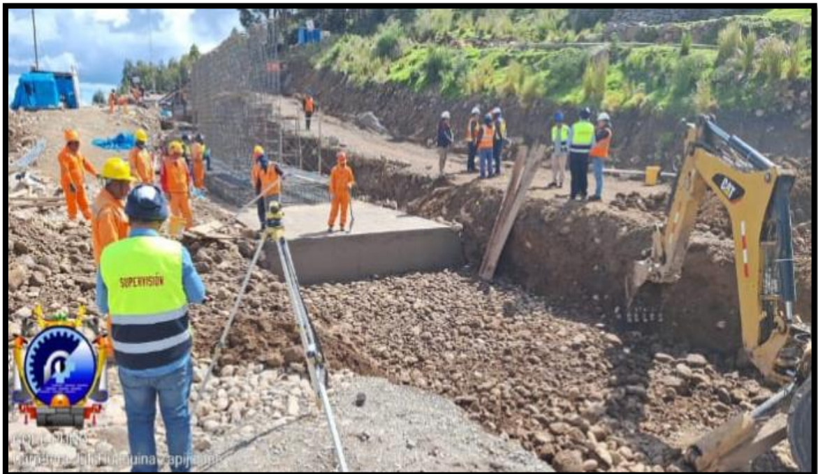
Avance de la obra: Mejoramiento camino vecinal de Huaquina – Juli.
