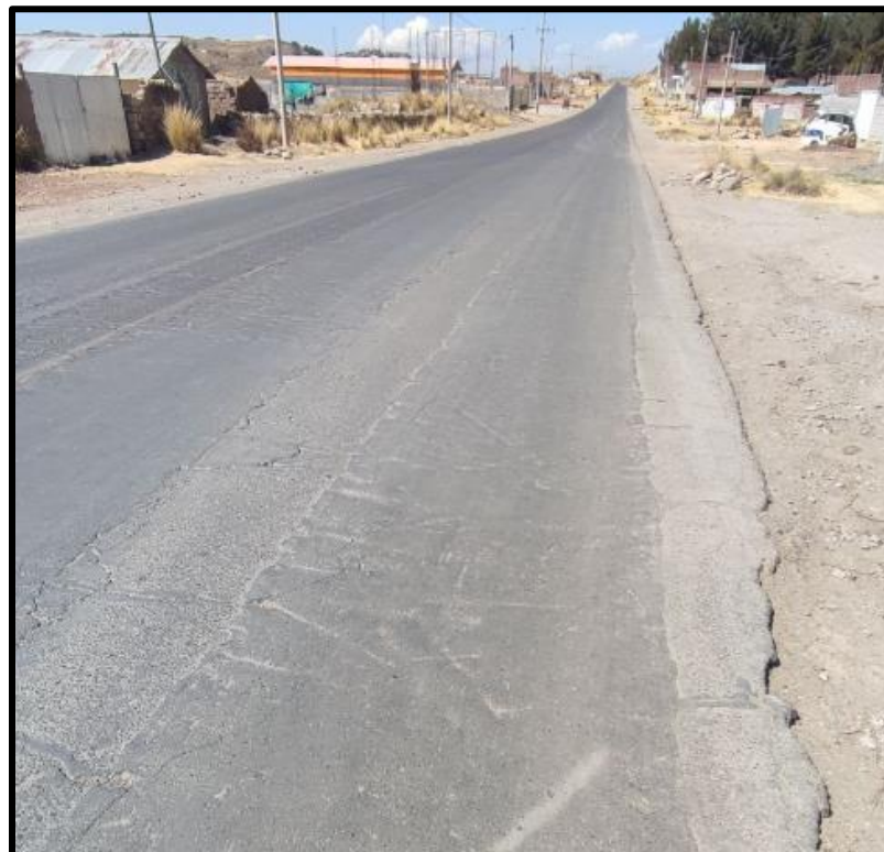
Figura 6: Parcheo severidad baja según PCI
