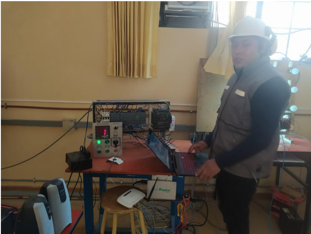
Puesta en marcha del seguidor solar y el PLC.
