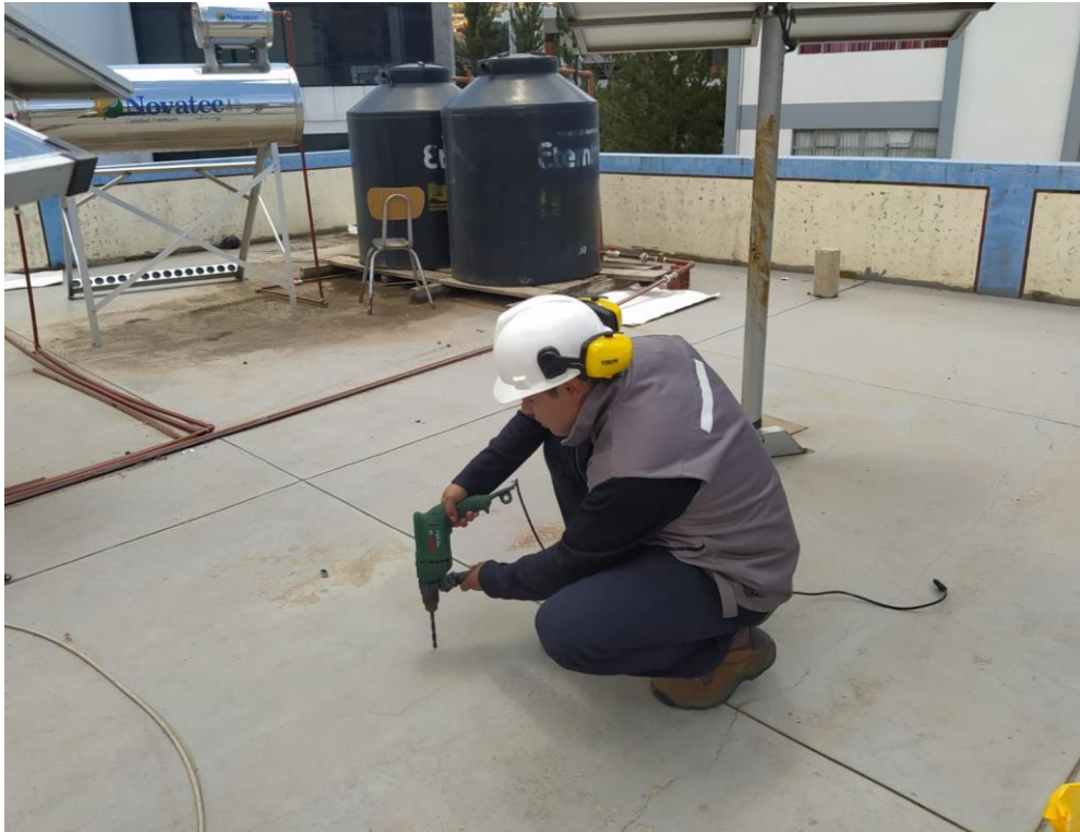
Instalación de la estructura del seguidor solar.
