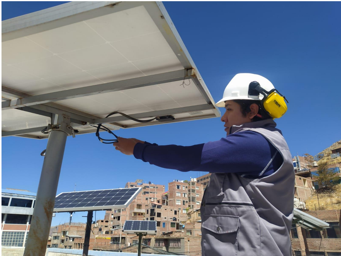
Instalación del seguidor solar.
