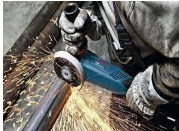
→ Área de corte de materiales
