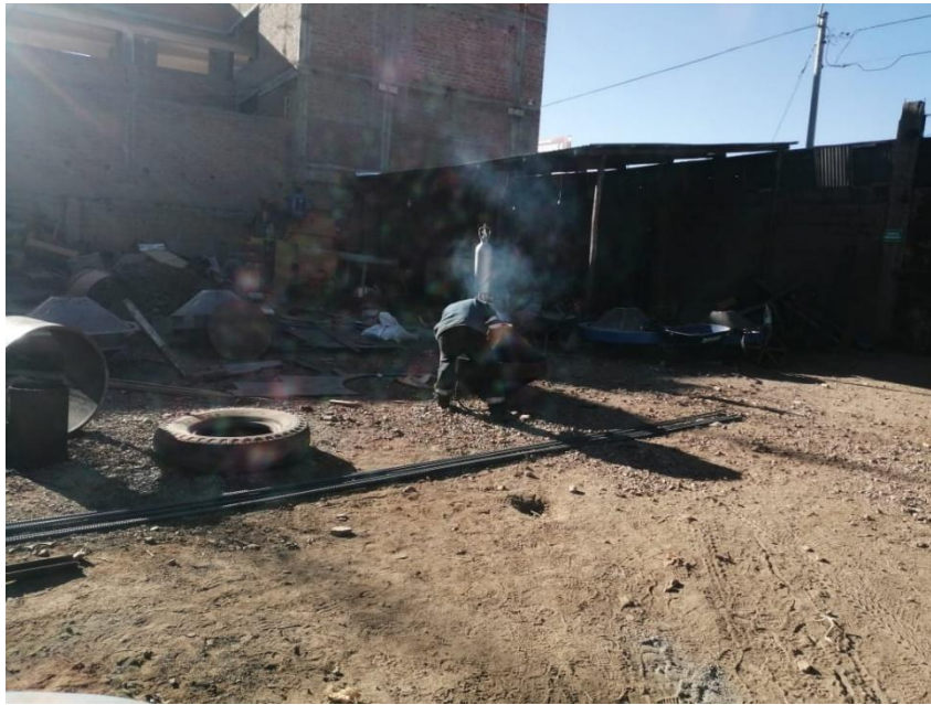
Figura 24: Area de soldadura con sistema abierto
