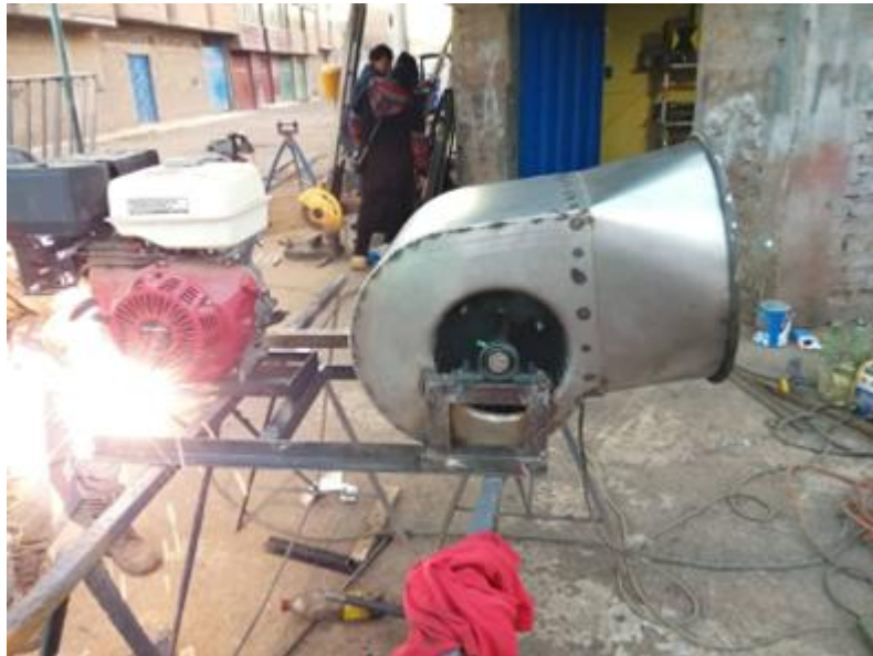
Figura 20: Imagen que representa a la medición de ruido en el área de soldadura en vía pública
