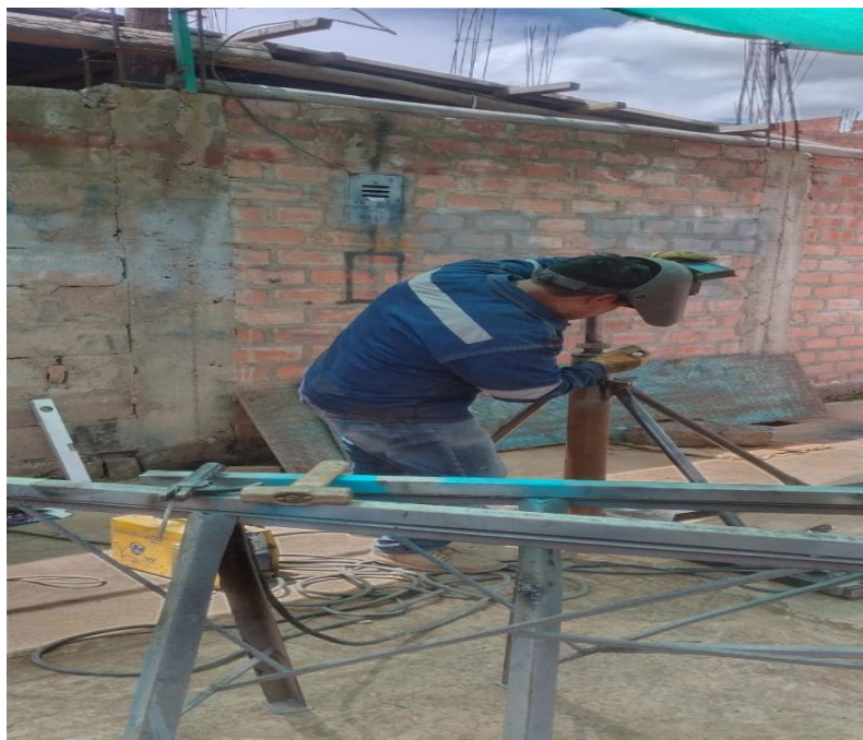
Figura 21: Personal soldando con EPPs básicos de soldadura
