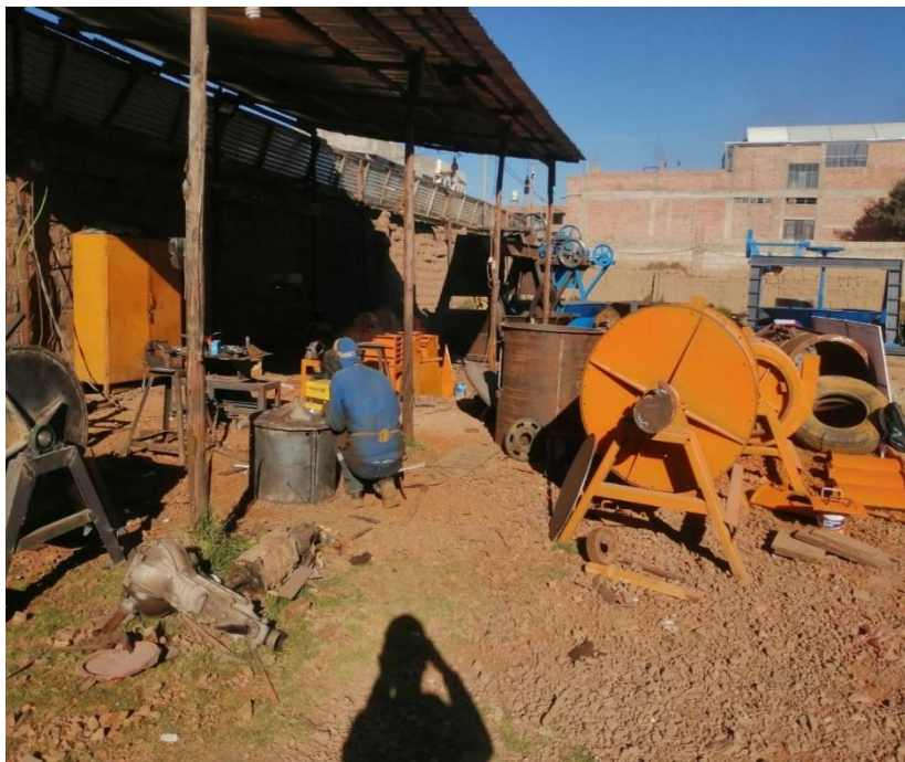
Figura 23: Personal haciendo uso de la soldadura por arco eléctrico con EPPs básicos
