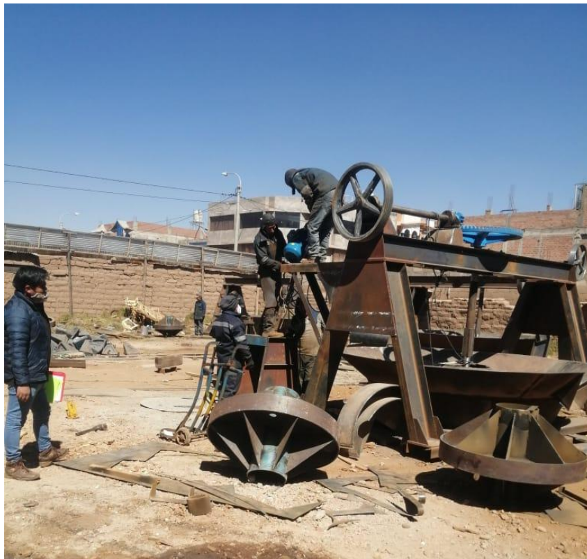
Figura 25: Soldadura con arco eléctrico
