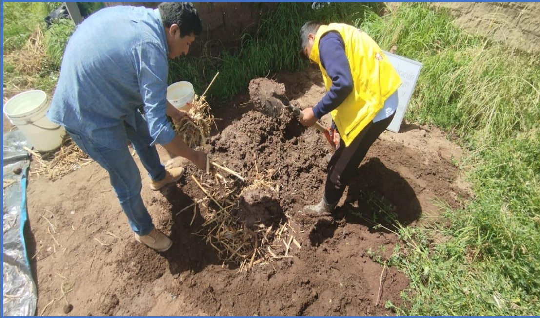
Fotografía 7. Preparación de la mezcla + fibra de totora
