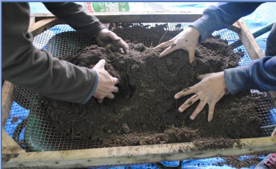
Fotografía 6. Preparación de la mezcla + fibra de totora
