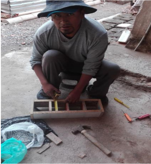
FOTO N° 05 elaboracion del molde
