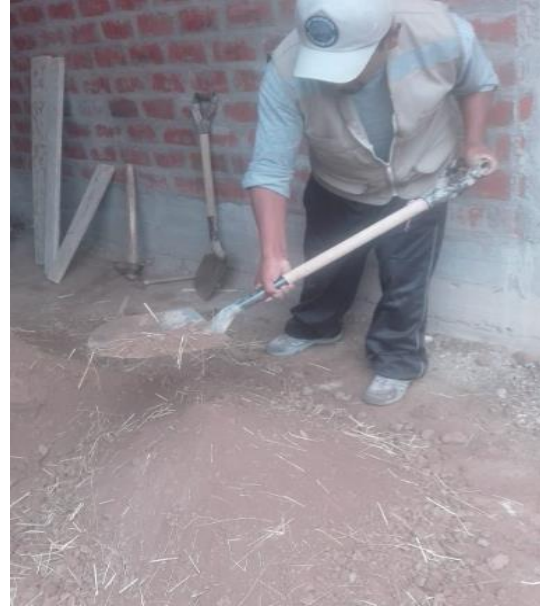
FOTO N° 10 mezcla de los materiales
