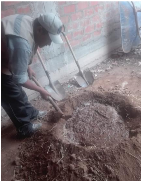
FOTO N° 11 mezcla con agua
