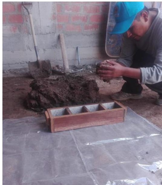
FOTO N° 14 elaboración de los bloques
