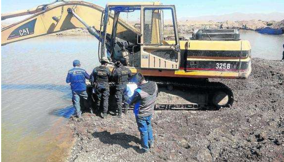
Fotografía 01. Se muestra la extracción de materiales
