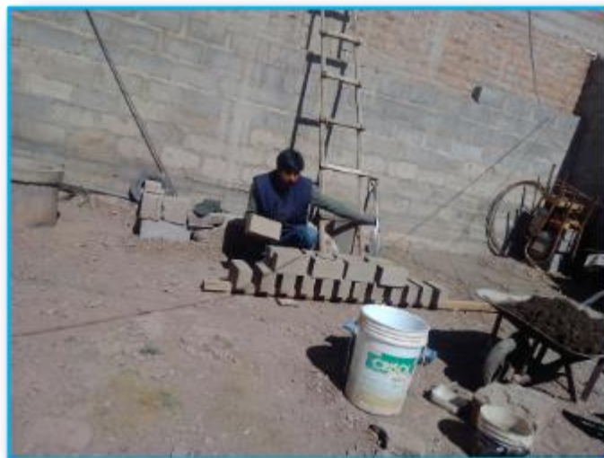
Fotografía 12. Proceso de curado del ladrillo estabilizado.
