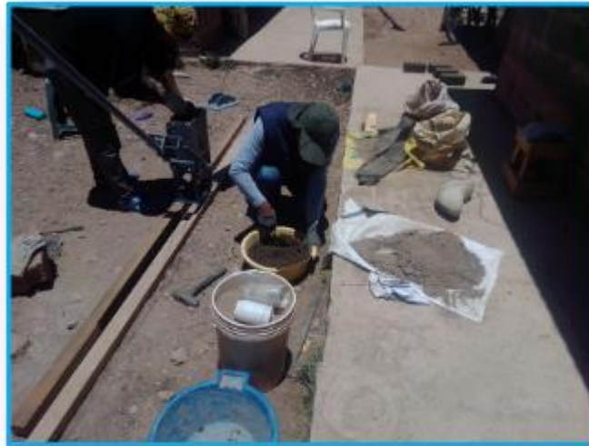
Fotografía 9. Proceso de combinación para la estabilización suelo cemento.
