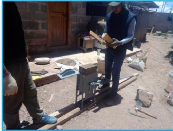
Fotografía 11. Proceso de compactación del ladrillo estabilizado.
