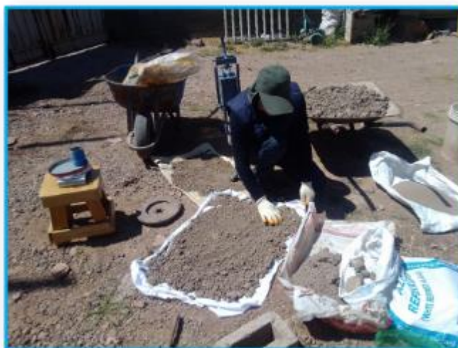
Fotografía 6. Proceso de separación de materiales para la mezcla de ladrillo.
