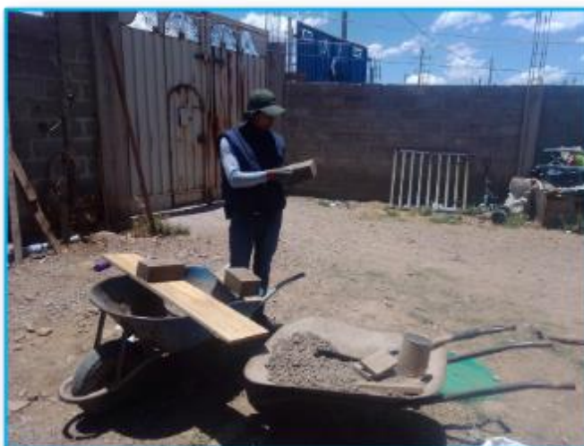
Fotografía 13. Verificación de las dimensiones del ladrillo estabilizado.
