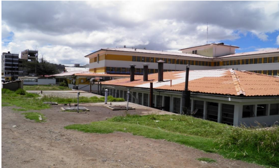
FOTOGRAFÍA 3: Reservorio de base y casa de motor
