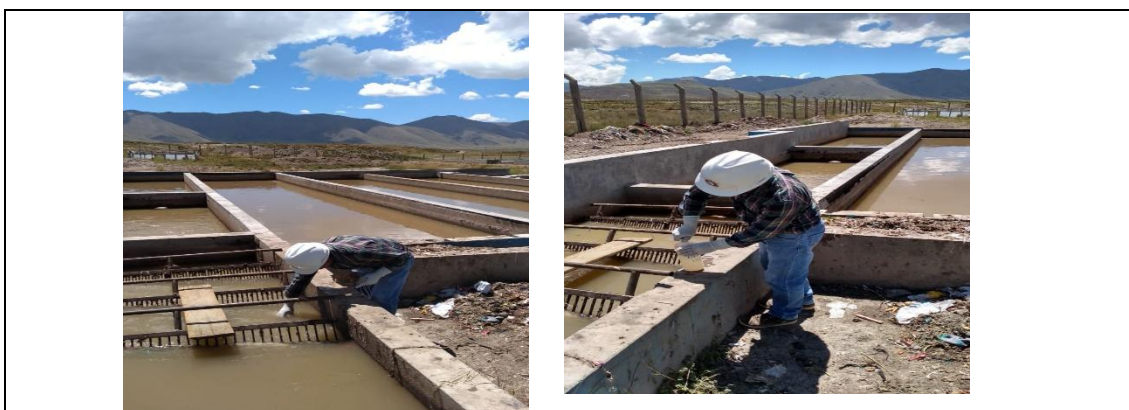
IMAGEN N° 06: Toma de muestra compuesta del agua residual en las siguientes coordenadas zona 19L ; 330251.47 m E; 8353026.44 m S
