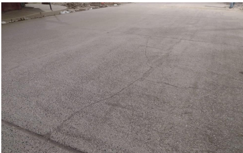
FOTO N° 08: Fisura lineal
