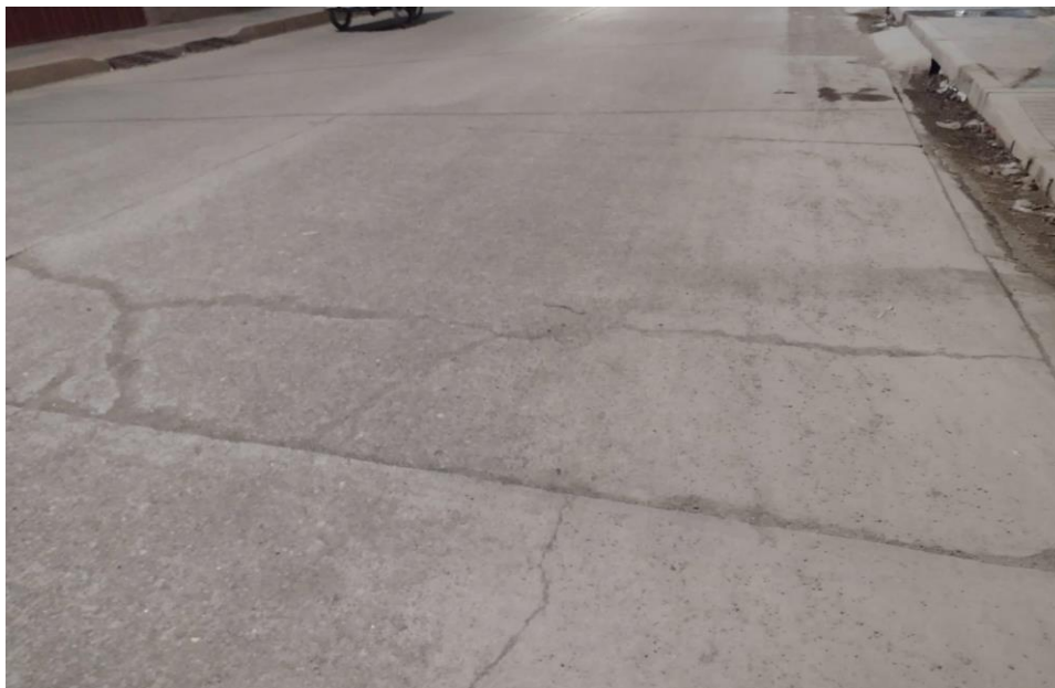
FOTO N° 03: Losa separada
