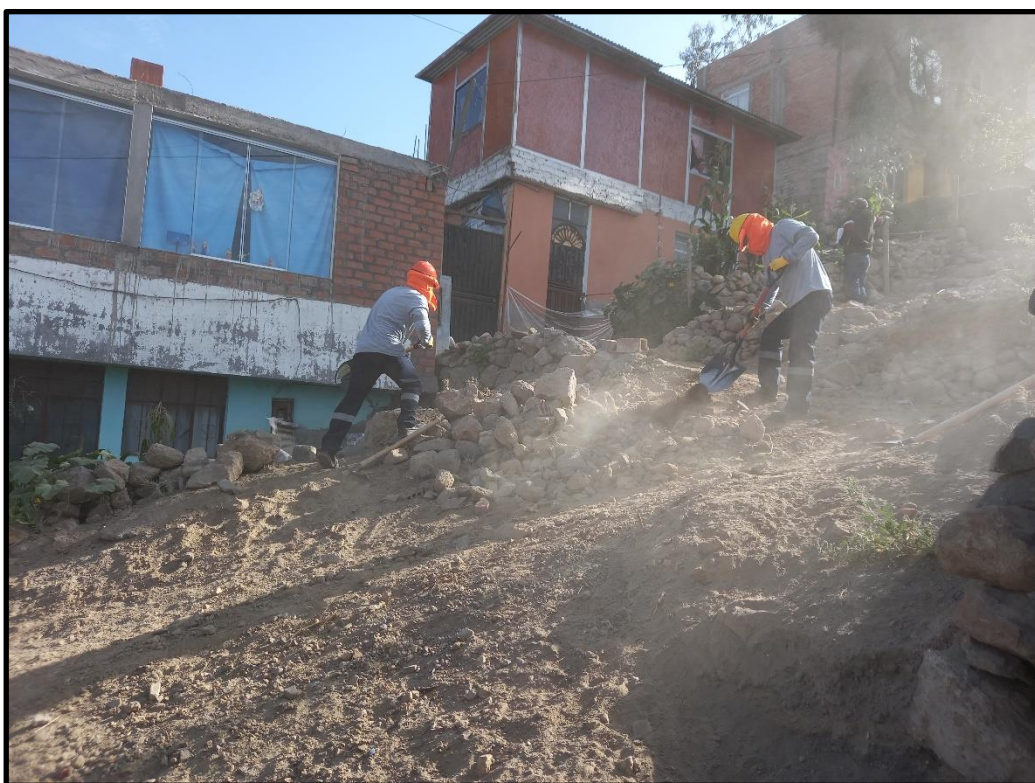
Limpieza Manual del terreno
