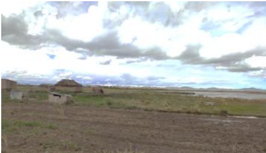
Vivienda afectada por inundación
