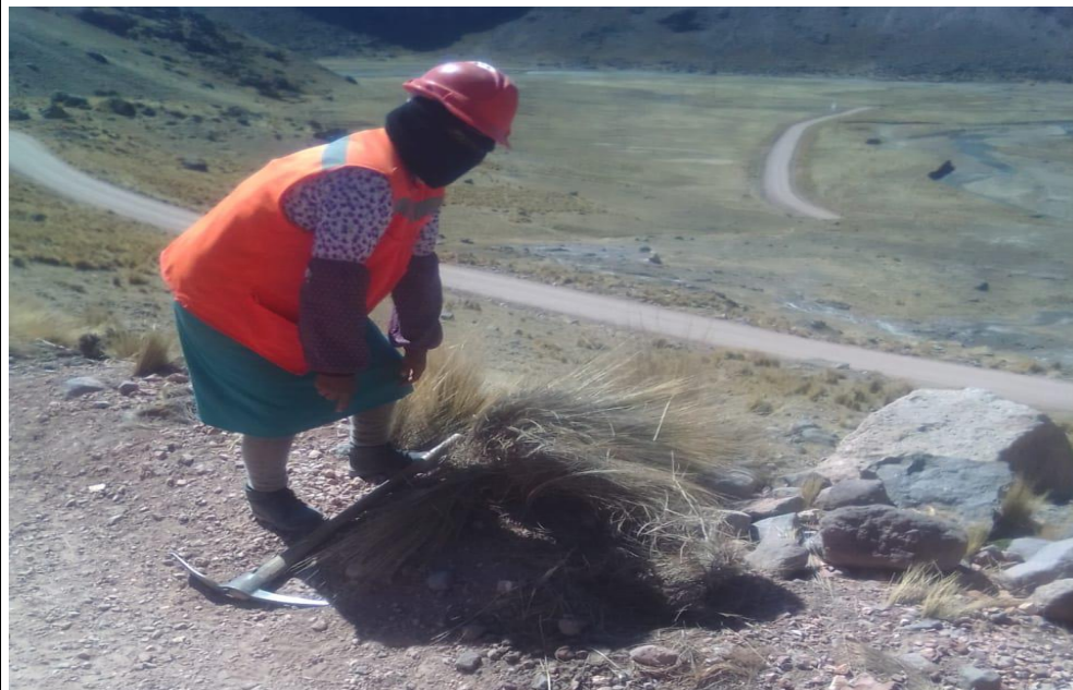
FOTO N° 15: Corte de vegetación en la progresiva 7+900
