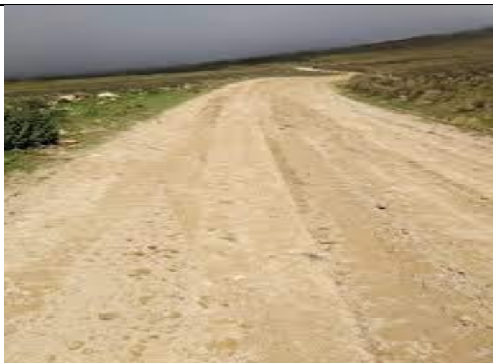
FOTO N° 01: Via en mantenimiento
