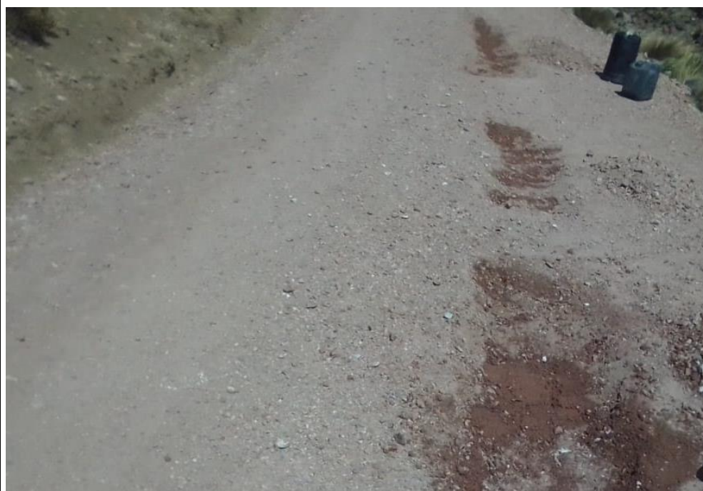
FOTO N° 12: Reparación de la vía con suma urgencia
