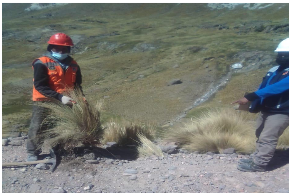
FOTO N° 14: Progresiva 7+700 requiere corte de vegetación
