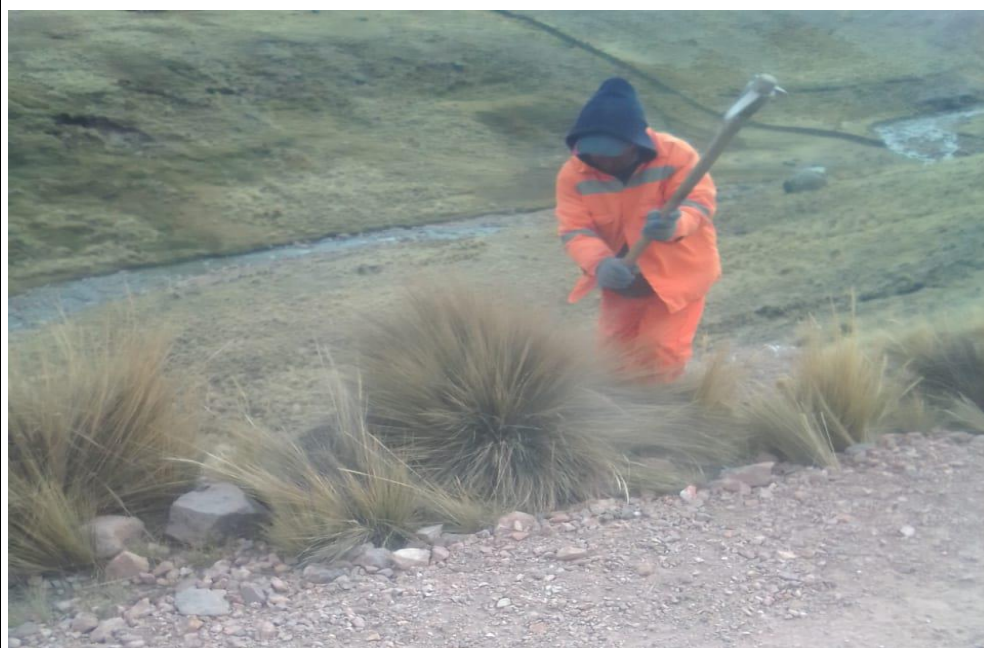
FOTO N° 16: Corte de vegetación en la progresiva 8+200
