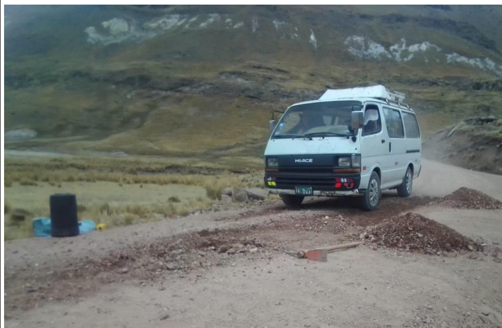
FOTO N° 08: El tramo 8+400 de la carretera Progresiva ha sido hallado en condiciones deficientes, lo que afecta la circulación de los vehículos y pone en riesgo la seguridad vial de los residentes.
