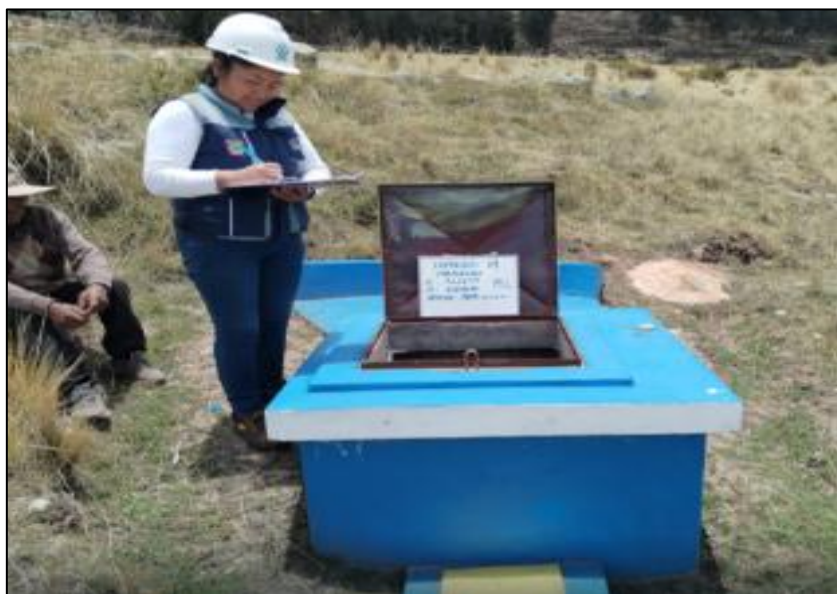
Fotografía 2. Verificación estructural de la captación 1 del sistema de abastecimiento.
