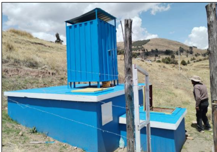
Fotografía 5. Inspección del reservorio y evaluación de condiciones operativas.
