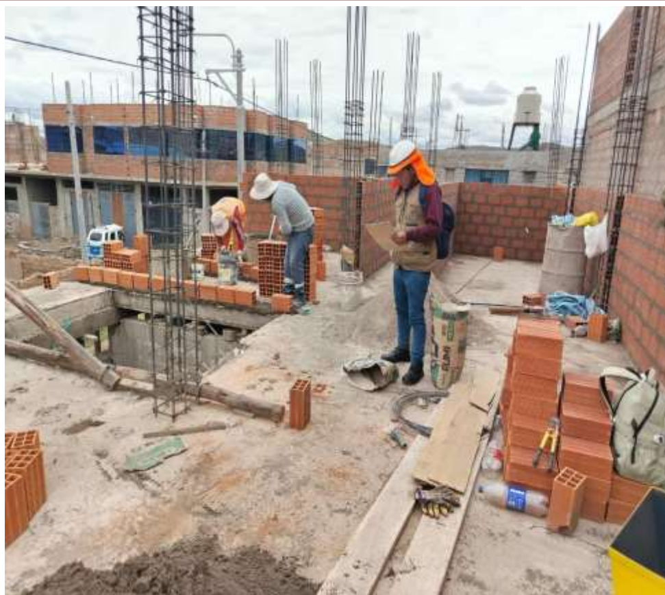
Fotografía 5. Inicio de asentado de muros (nuevo paño)
