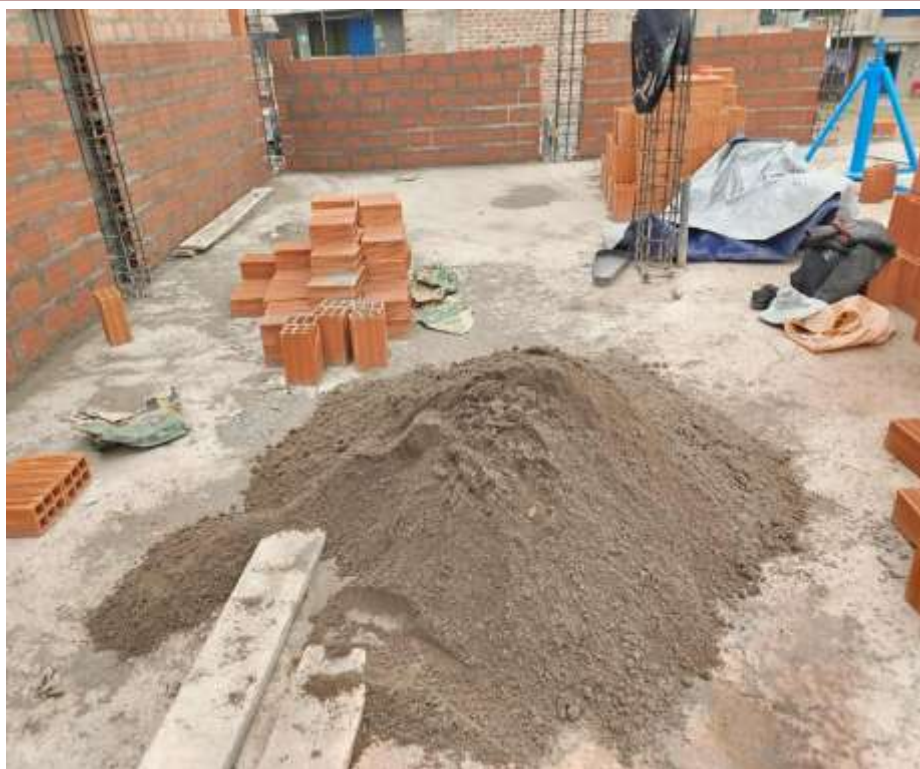
Fotografía 3. Se muestra el conjunto de agregados utilizados para la preparación del mortero en el asentado de muros.
