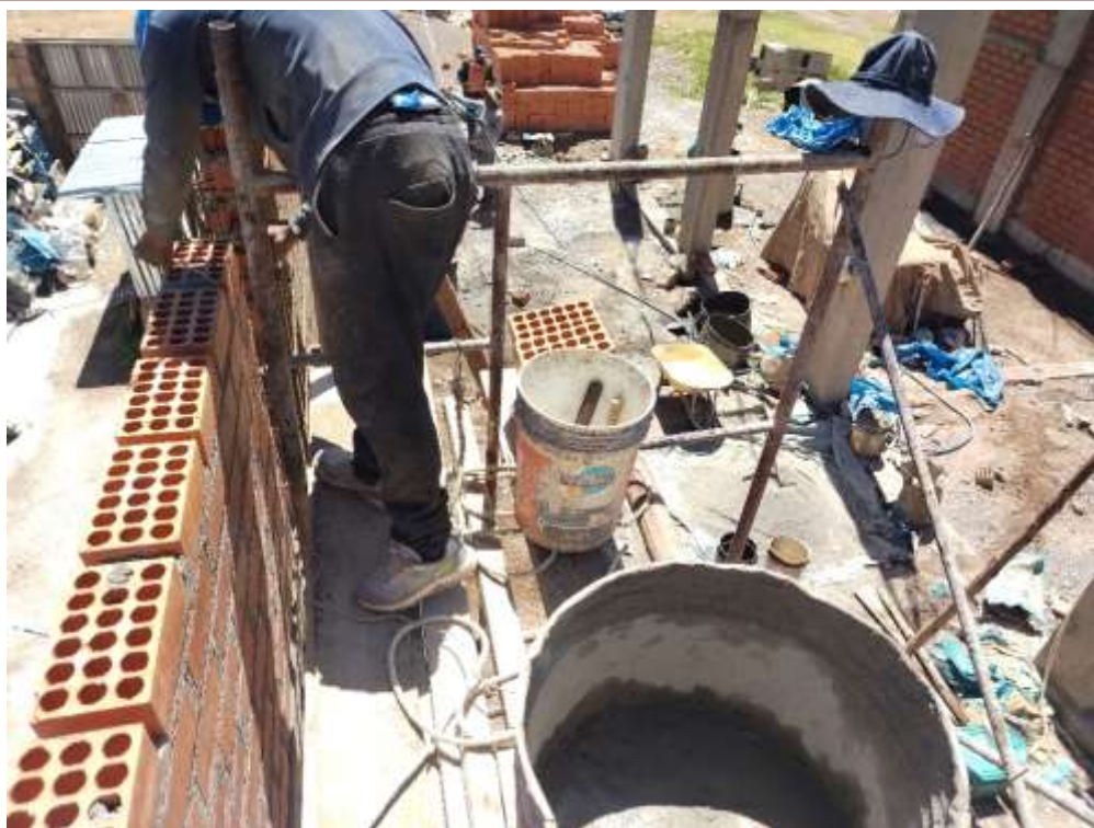
Fotografía 7. Asentado de muros altos
