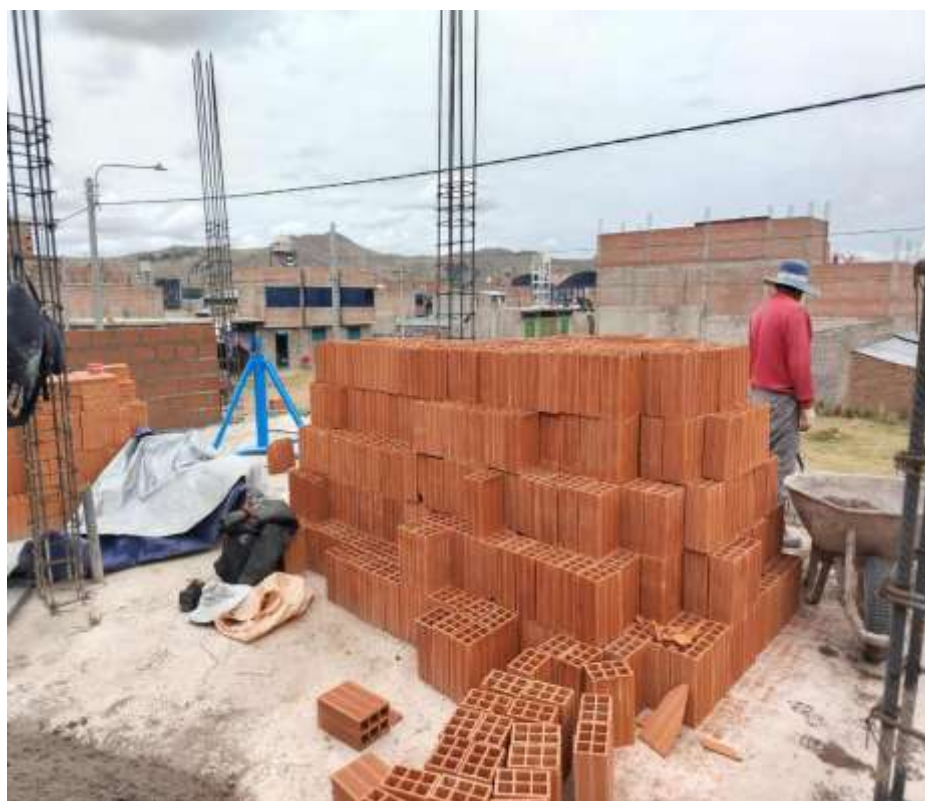
Fotografía 4. Ladrillos requeridos para el asentado de muros
