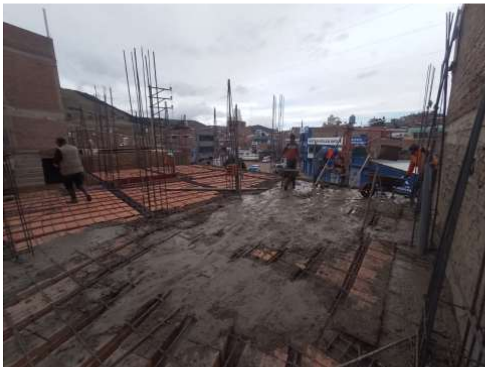
Fotografía 6. Distribución del concreto sobre la losa en la Obra I.
