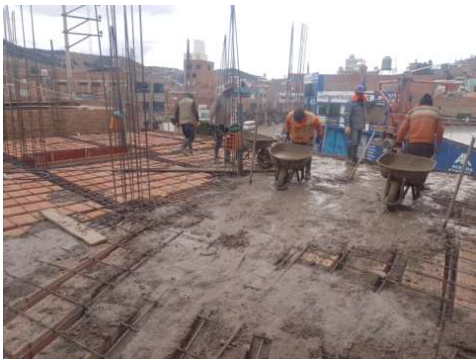
Fotografía 4. Vaciado de losas aligeradas en la obra de edificación de galerías comerciales.
