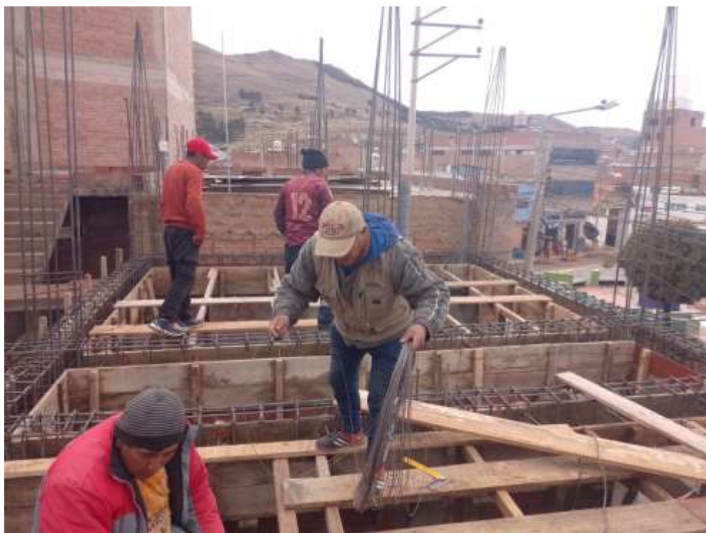
Fotografía 20. Instalación del entablado de madera y ajustes.
