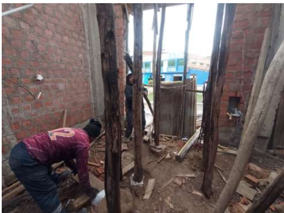
Fotografía 17. Instalación de puntales en la obra II.
