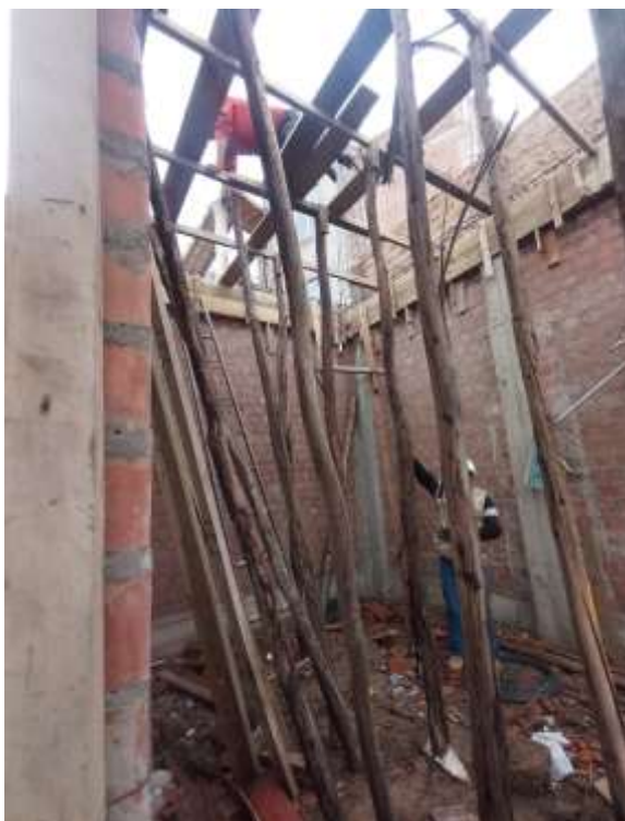
Fotografía 14. Instalación de puntales en la obra de edificación de la vivienda multifamiliar.
