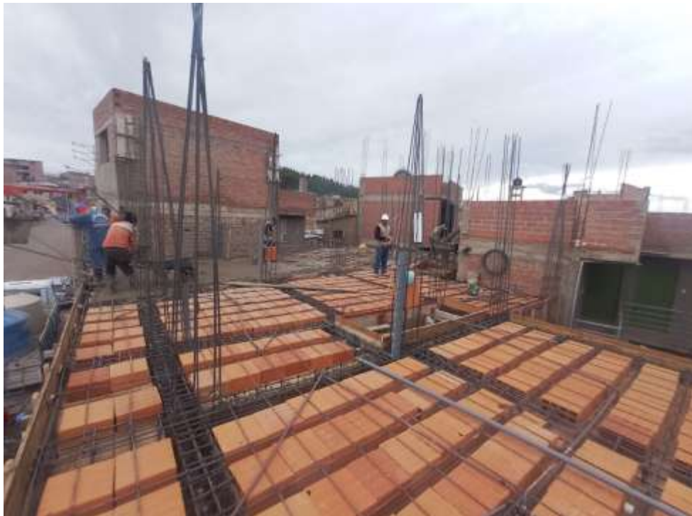
Fotografía 10. Inicio del vaciado de losas aligeradas en la obra I.
