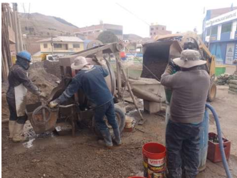
Fotografía 3. Proceso de elaboración del concreto para el vaciado de losas.
