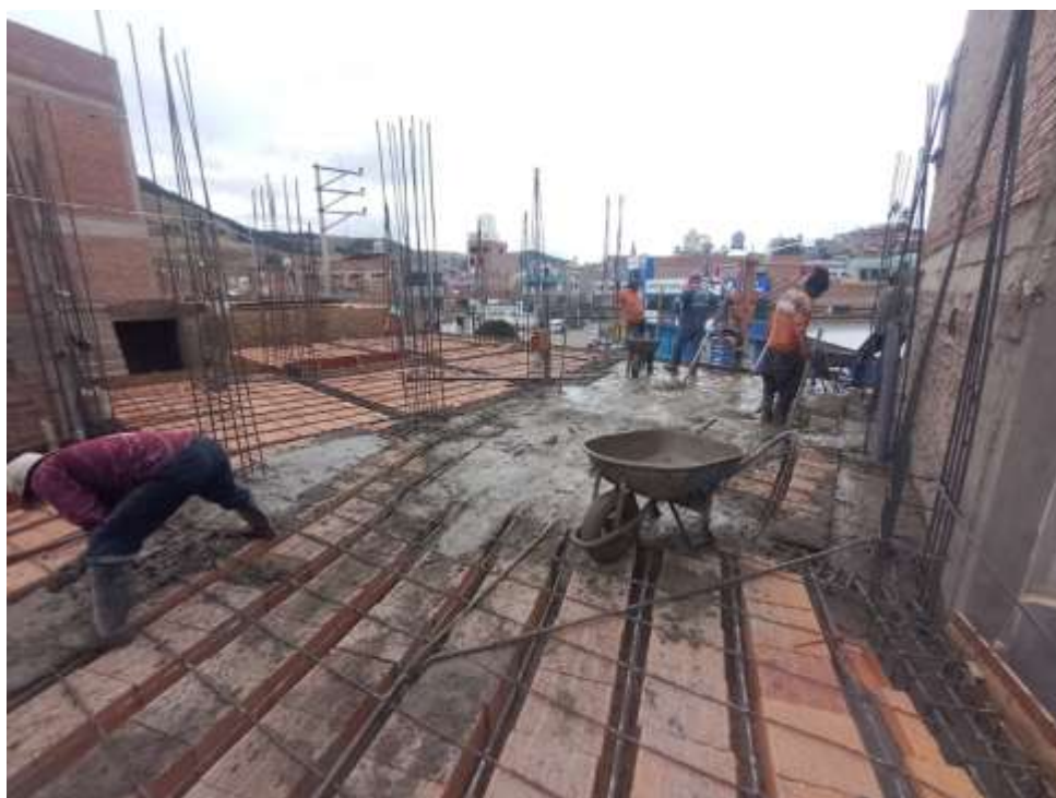
Fotografía 5. Preparación del acceso para carretillas en la obra I.
