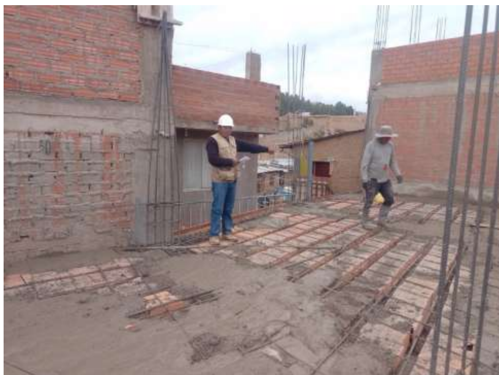
Fotografía 11. Supervisión operativa del proceso de vaciado en la obra I.
