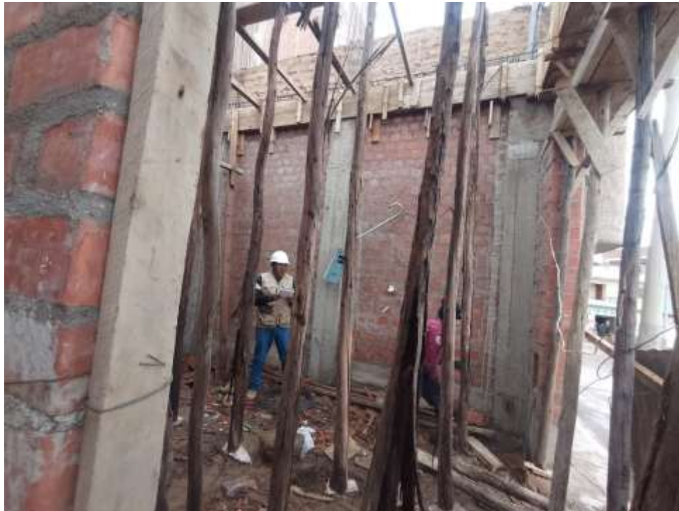
Fotografía 15. Instalación de puntales en la obra de edificación de la obra II.
