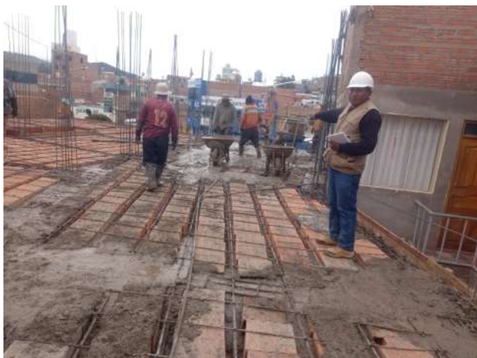
Fotografía 12. Supervisión operativa del proceso de vaciado en la obra II.
