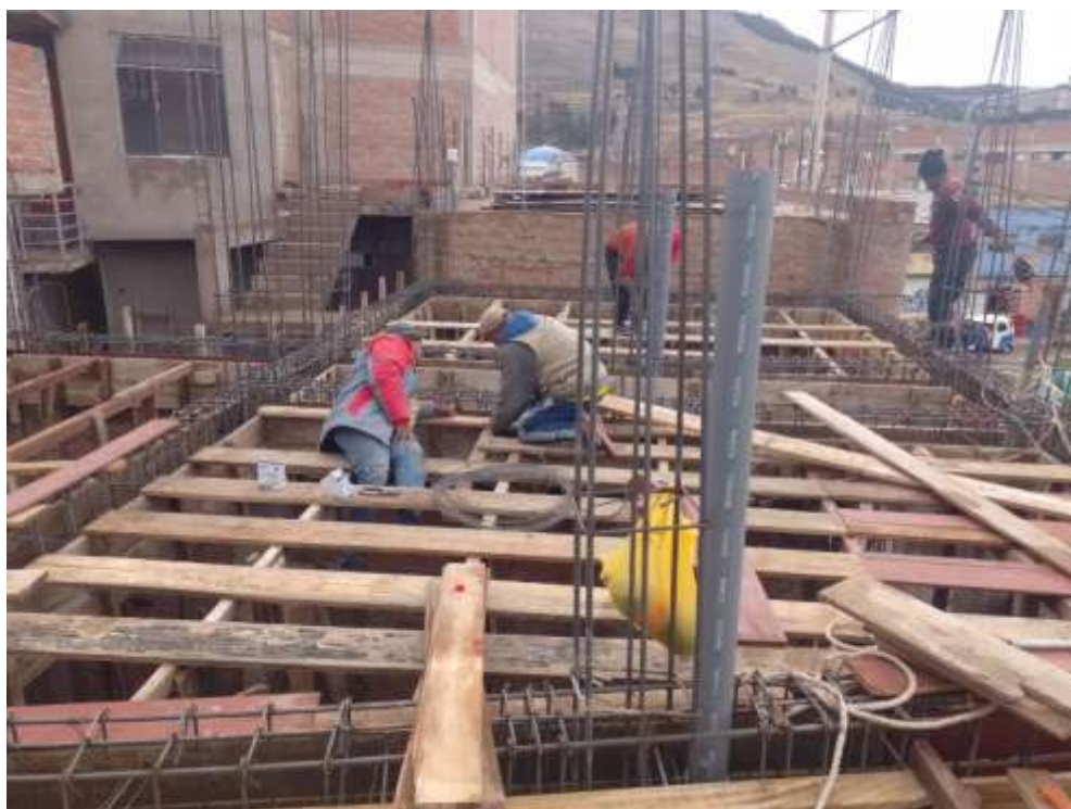
Fotografía 19. Instalación del entablado de madera en la obra de edificación la vivienda multifamiliar.
