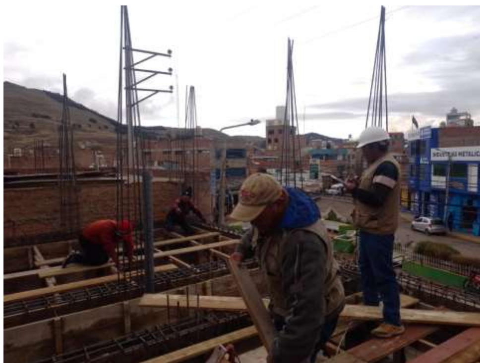
Fotografía 18. Instalación del entablado de madera en la obra de edificación de galerías comerciales.
