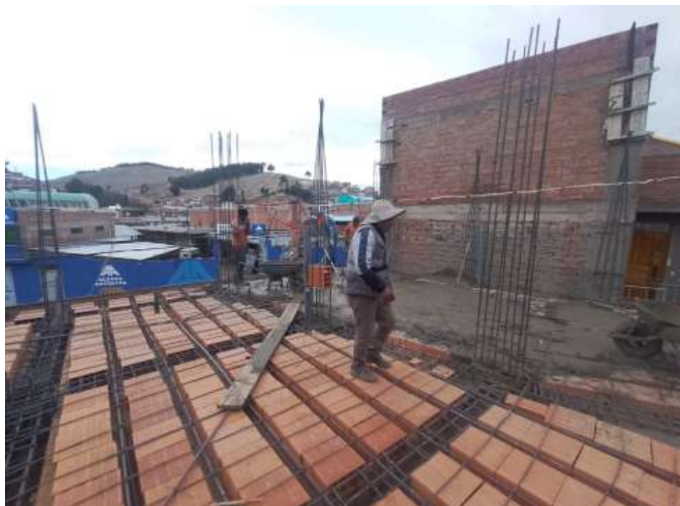
Fotografía 8. Preparación del acceso para carretillas en la Obra II.
