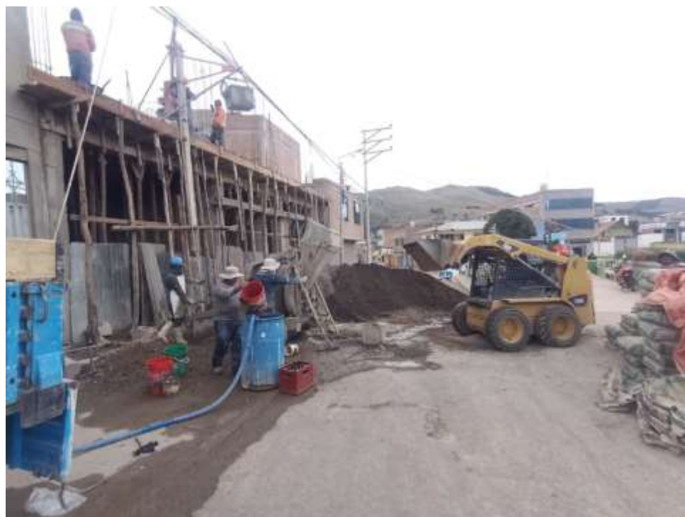
Fotografía 2. Inicio del vaciado de losas aligeradas en la 1ra obra.
