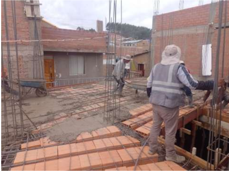
Fotografía 9. Vaciado de losas aligeradas.
