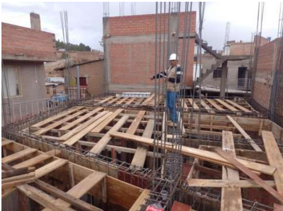
Fotografía 16. Supervisión operativa del proceso de entablado de losas en la obra II.
