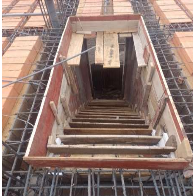
Fotografía 7. Encofrado de losas aligeradas de la primera obra.
