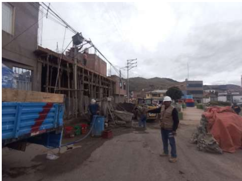
Fotografía 1. Presentación de la obra de edificación de galerías comerciales.
