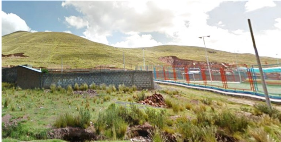
Figura 42 Vista Por El Norte
