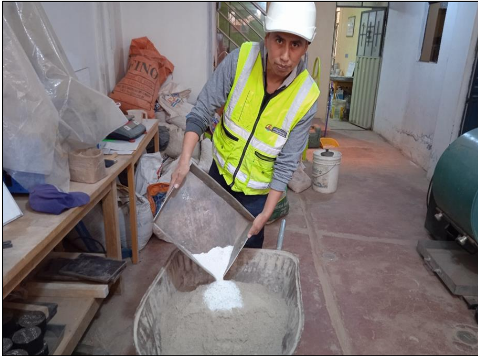
Fotografía 08. Adición de residuos de acero y vidrio olido al concreto.
