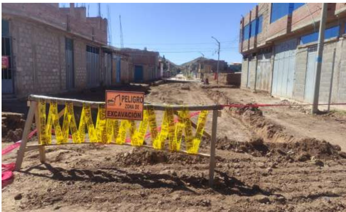
Fotografía N°.3. Partida de excavación Obra de mejoramiento de calle. (Obra 1)
