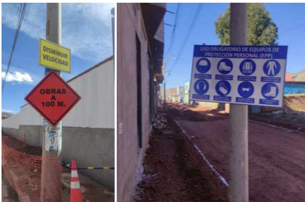
Fotografía N°.9. Señalización en las obras estudiadas.
