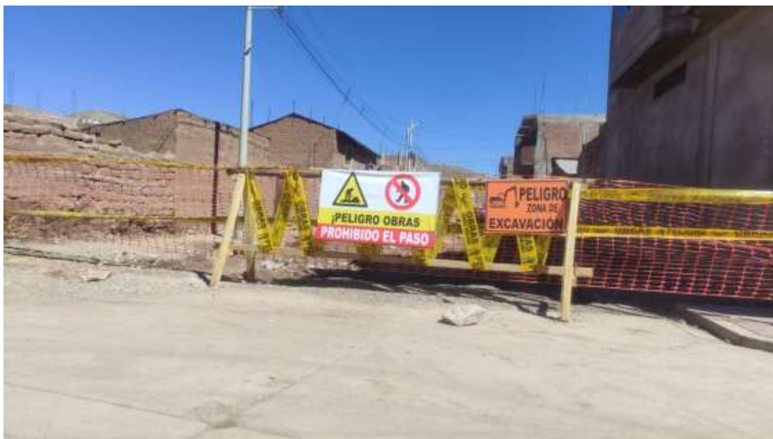
Fotografía N°.4. Partida de excavación Obra de mejoramiento de calle. (OBRA 2)
