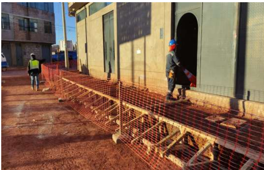
Fotografía N°.7. Partida de encofrado Obra de mejoramiento de vereda. (OBRA 1)
