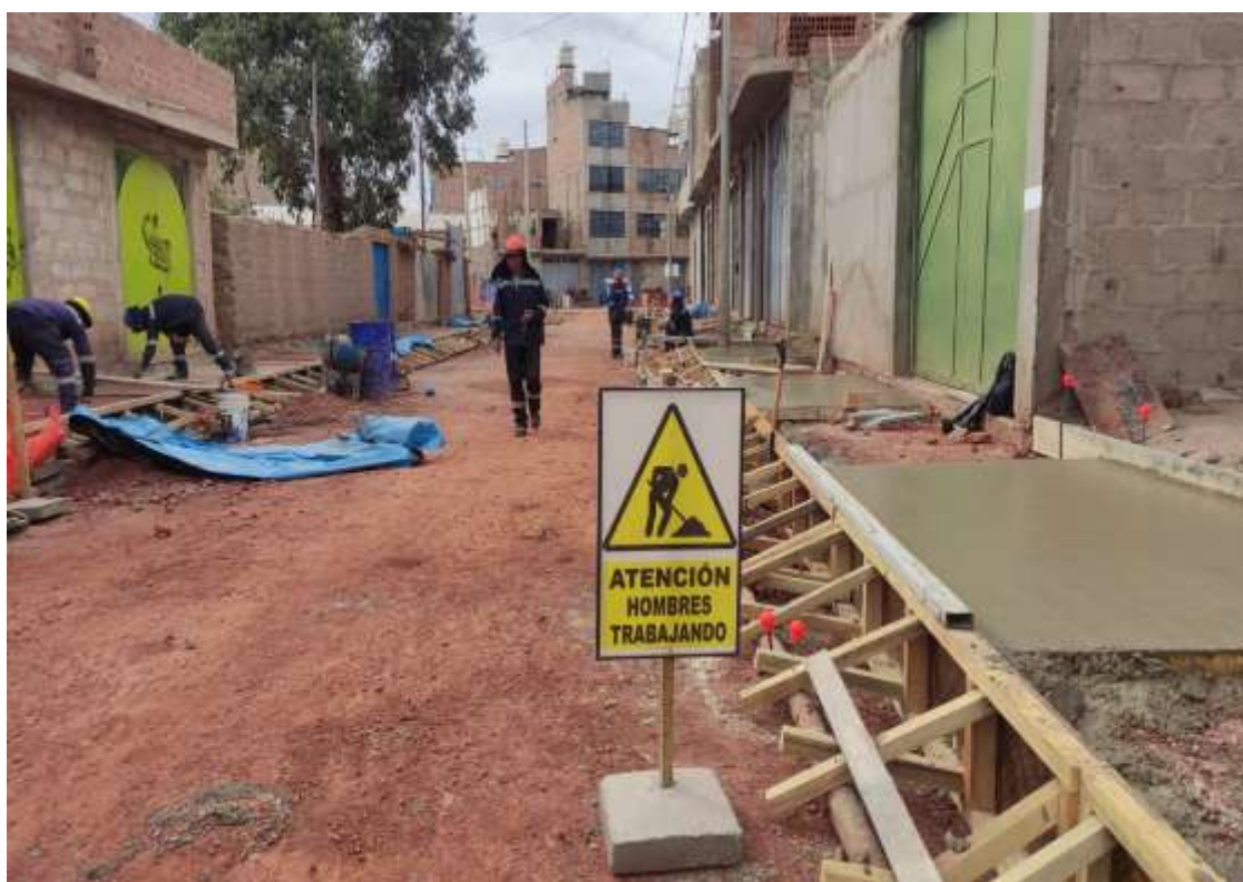
Fotografía N°.5. Obra de mejoramiento de vereda. (OBRA 1)
