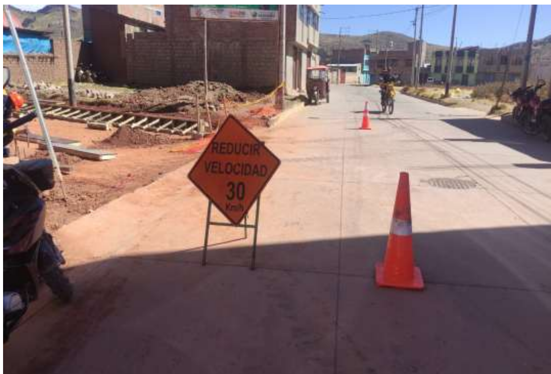
Fotografía N°.6. Obra de mejoramiento de vereda. (OBRA 2)
