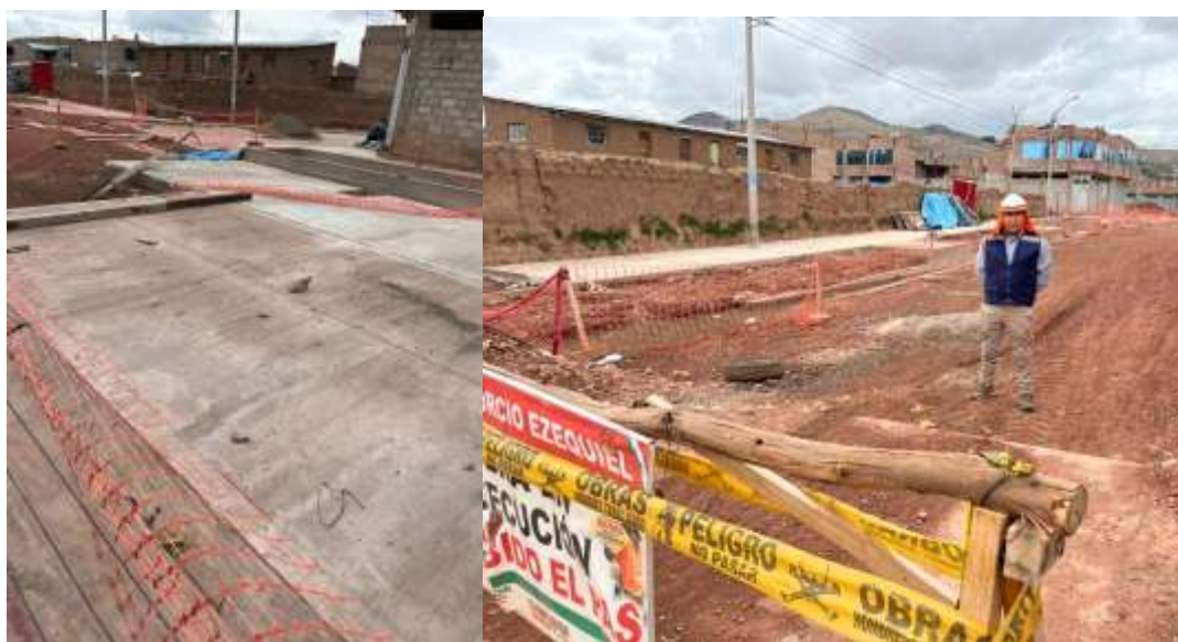
Fotografía N°.2. Obra de mejoramiento de calle (Obra 1)
