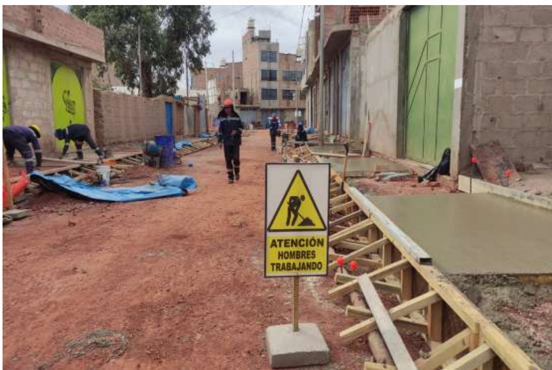
Fotografía N°.8. Partida Nivelación final Obra de mejoramiento de vereda. (OBRA 2)
